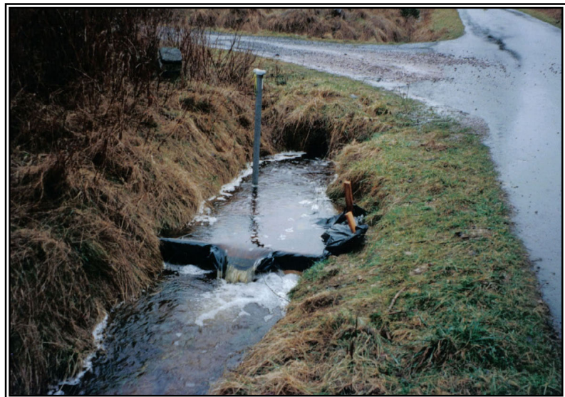
Bild 4-5 Pegelanlage P1 mit dem vorgelagerten Messwehr W3a während des Hochwasserereignisses im Februar 2002.
