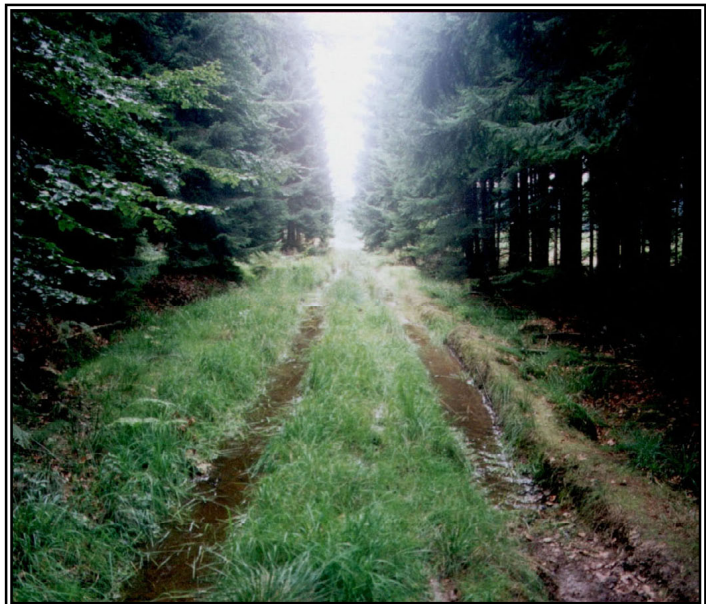
Bild 3-17 Verdichtete Fahrspuren am mittleren Querweg des Modellhanges Hölzerkopf im Sommer 1999.
