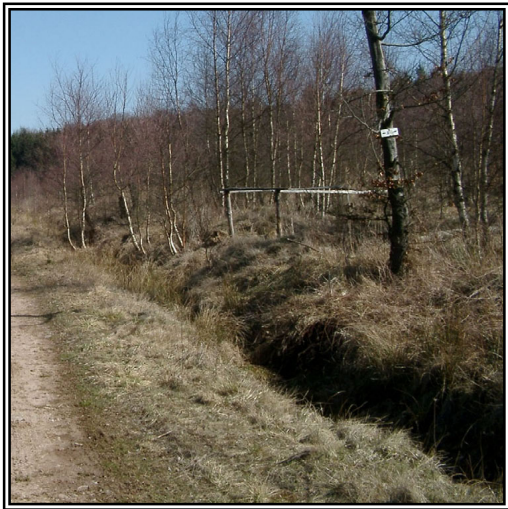
Bild 6-5 Entwässerungsgraben entlang des mittleren Querweges des Modellhanges Hölzerkopf.
