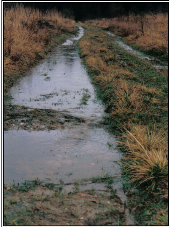
Bild 3-18 Oberflächenabfluss in den Fahrspuren eines unbefestigten Forstweges (mittlerer Querweg des Modellhanges Hölzerkopf) während eines Niederschlagsereignisses.
