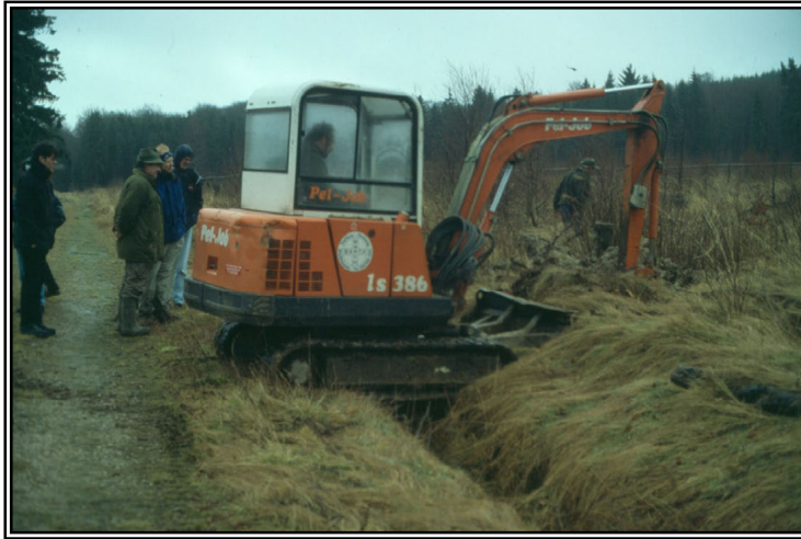
Bild 1-2 Anlage der Profilgruben mit einem Bagger (hier Profil C3).
