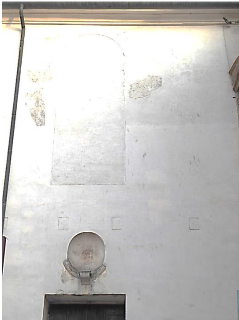
Ostwand des ehemaligen Salone degli Cavalli, Palazzo Ducale, Sabbioneta Fotografie: Julia Schmidt, 2018.
