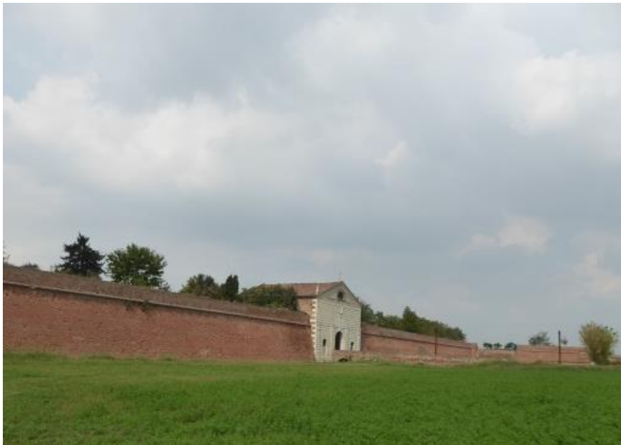
Porta Imperiale im Verlauf der Stadtmauer von Sabbioneta Fotografie: Julia Schmidt, 2018.
