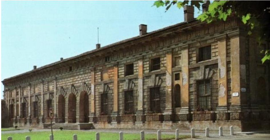
Putzrustika der Fassade des Palzzo del Te, Mantua
