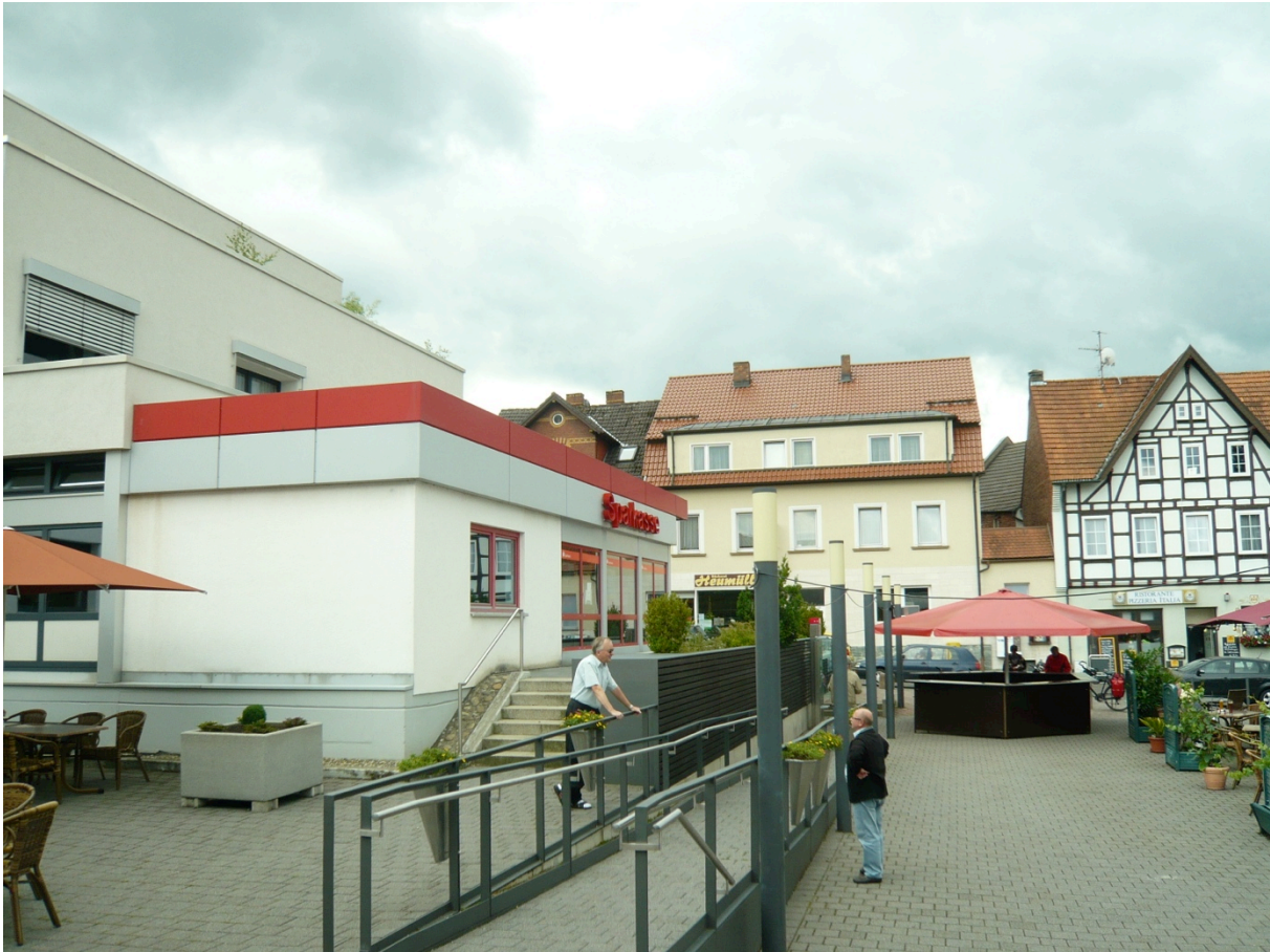
Abb. 22: Der Kontrast von traditionellen Hausformen (Fachwerkhaus) und Neubauten in unmittelbarer Nähe zeigt sich exemplarisch im Ortskern von Hilders (DÖLLE 2012).
