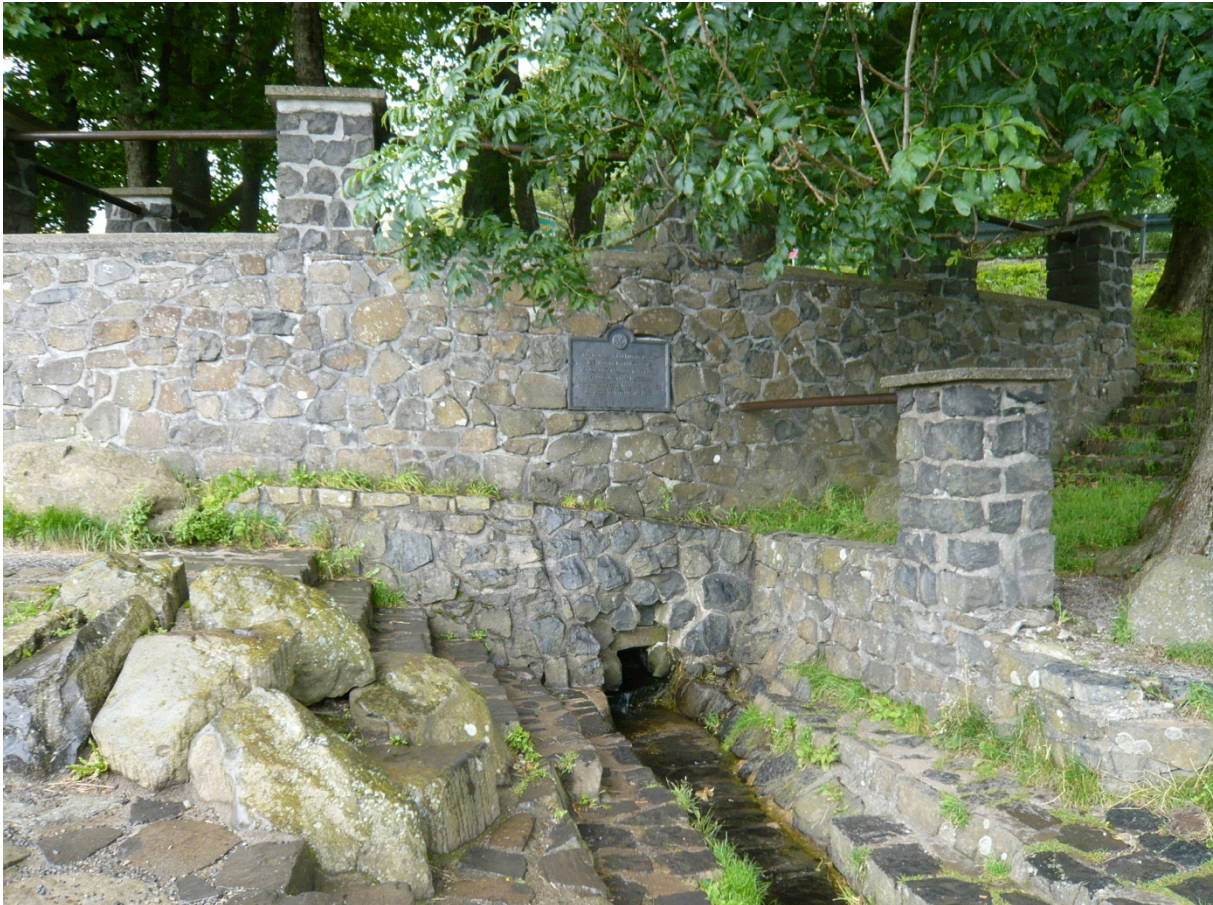
Abb. 16: Quelleinfassungen, wie die der Fulda am Westhang der Wasserkuppe, stellen eine erhebliche Gefahr für die Gewässerartenvielfalt und Gewässerökologie dar (DÖLLE 2012).
