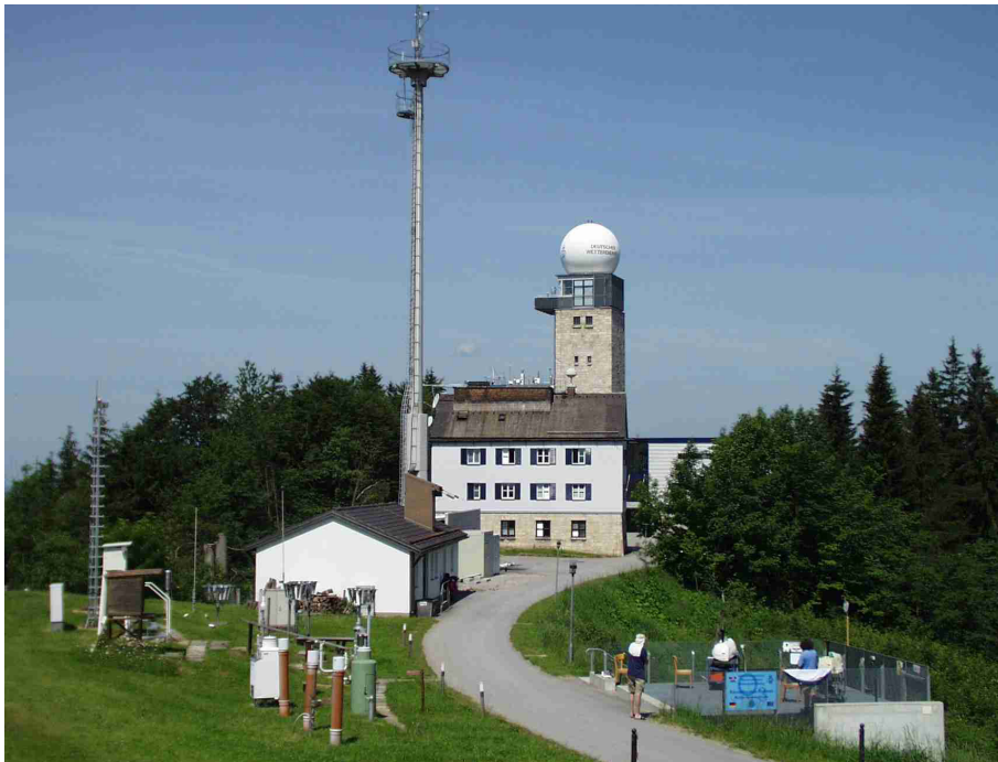
Abbildung 7.1: Aufnahme des Meteorologischen Observatoriums Hohenpeißenberg von Osten; im Vordergrund die vom Gipfel heranführende Zufahrtsstraße mit meteorologischen Messfeldern und Windmessturm; im Hintergrund das Observatorium mit Radarturm und Messplattformen auf dem Alt- und Neubau; der Einlass für die Formaldehydmessungen während HOHPEX04 befand sich auf der Messplattform des Neubaus, etwa auf halber Höhe südlich des Radarturms
