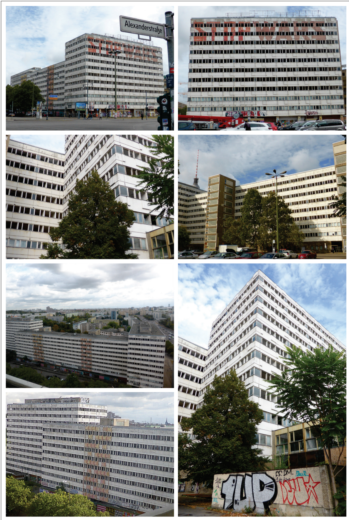
Abb. 23: Ansichten auf den leer stehenden Bürokomplex Haus der Statistik in Berlin Quelle: eigene Aufnahmen
