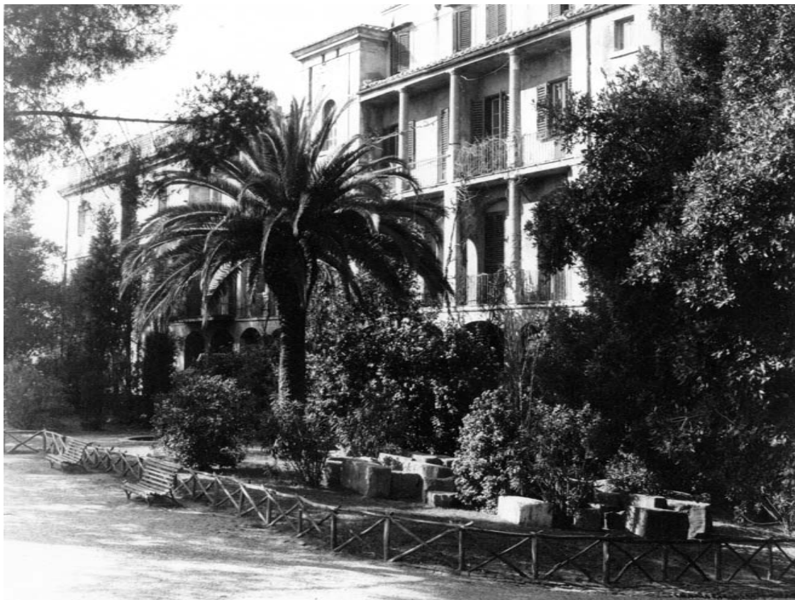
Abb. 2: Die Casa Tarpea (Ansicht von der Gartenseite)
