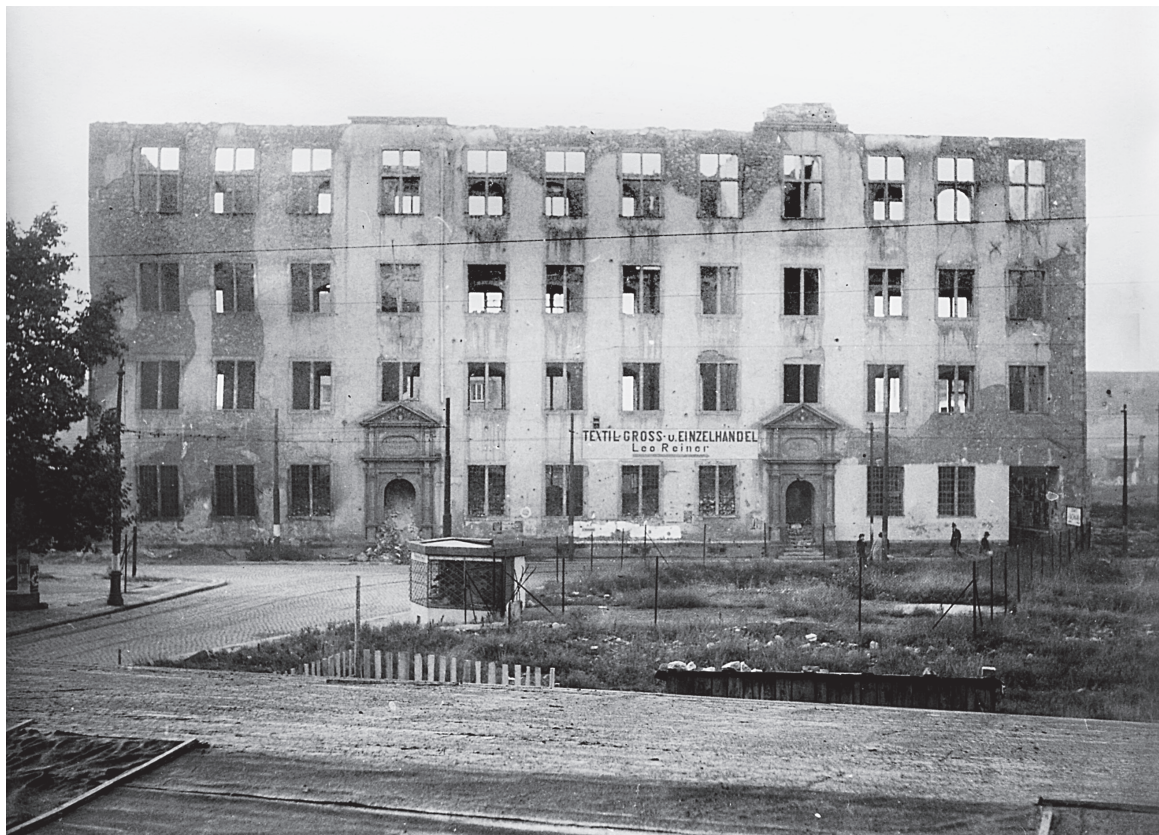
Die zerstörte Domus Universitatis nach 1945. Quelle: StA Mainz, BPSF 1827 A.
