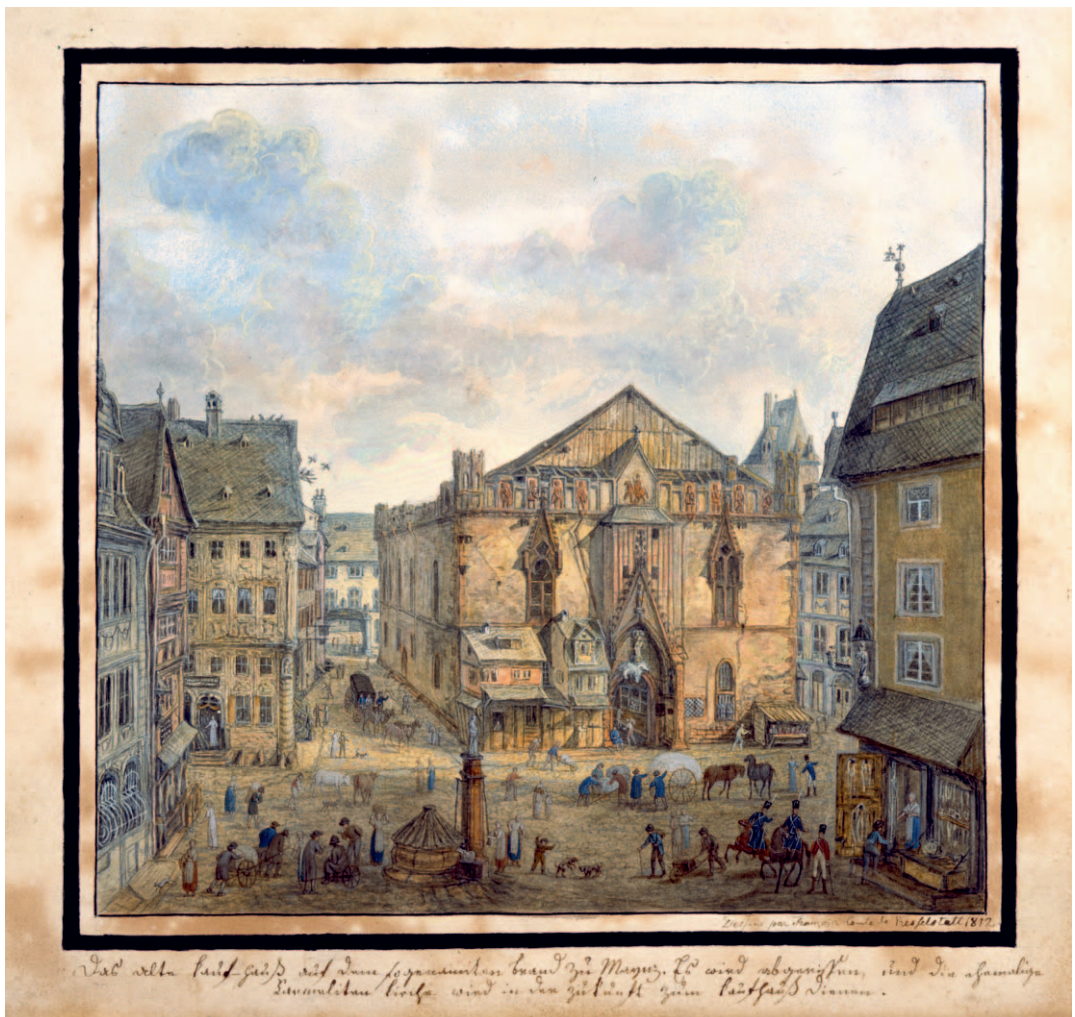
Das Kaufhaus am Brand, von Franz Graf v. Kesselstatt 1812 (Original „François Comte de Kesselstatt“).
