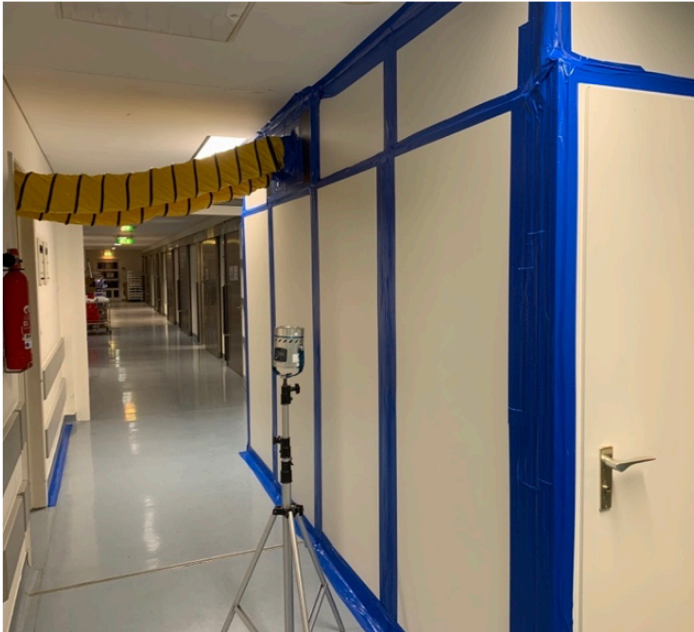
Feste Staubschutzwand mit Tür und Abluftleitung nach außen
