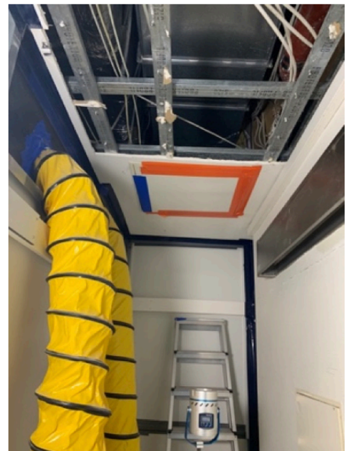
Messung bei geöffneter Decke
