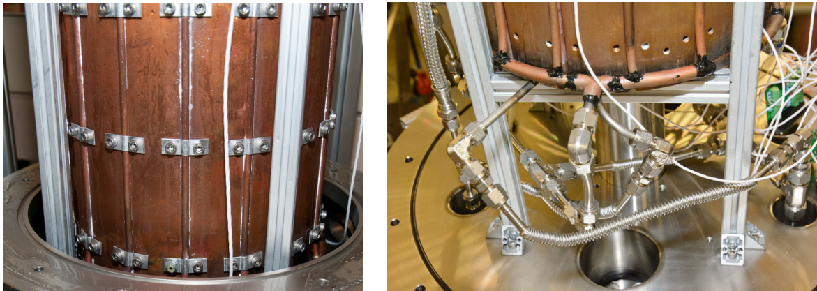
(a) Kühlleitungen am Speicherrohr.
