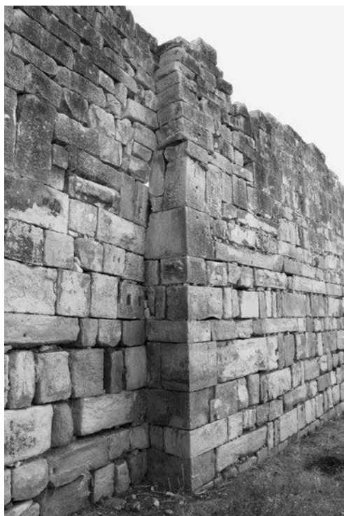
Abb. 296 Thignica. Nordkurtine mit Eckverband eines möglichen Vorgängerbaus
