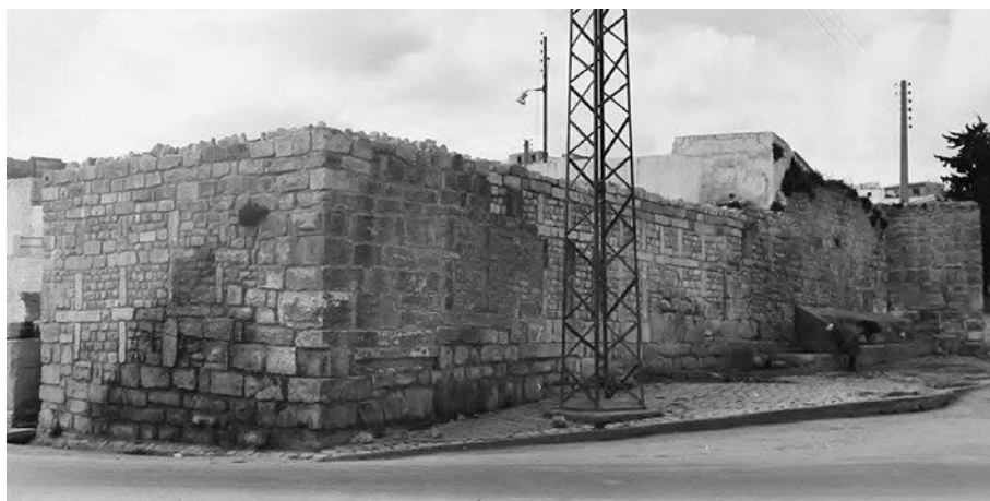
Abb. 397 Thubursicum Bure. Nordkurtine Bresche mit späterer Flickung westlich von Turm D
