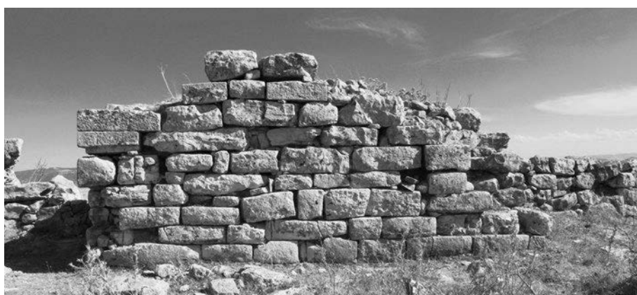
Abb. 413 Thugga. Stadtmauer Westseite des byzantinischen Turm B
