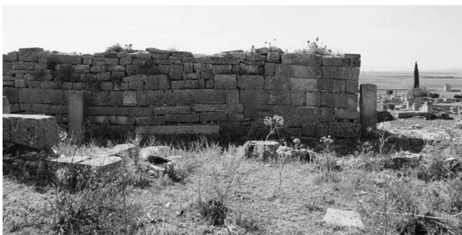
Abb. 226 Mustis. Westlicher Abschnitt der Nordwestkurtine mit Spolienmauerwerk
