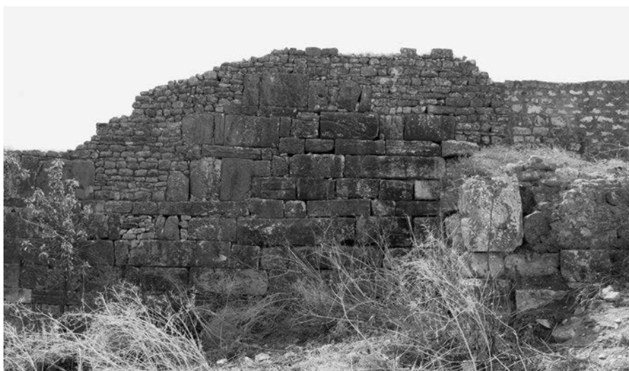
Abb. 358 Agbia. Nordkurtine Westhälfte mit Spolien und Ansatz von Turm A
