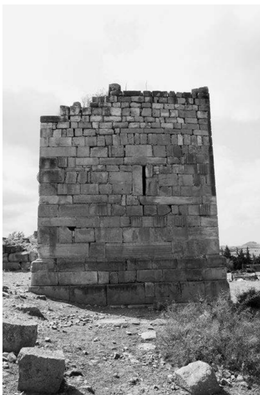
Abb. 318 Thignica. Ostseite des Nordostturm B mit Schießscharte, Spolien und Sockelzone
