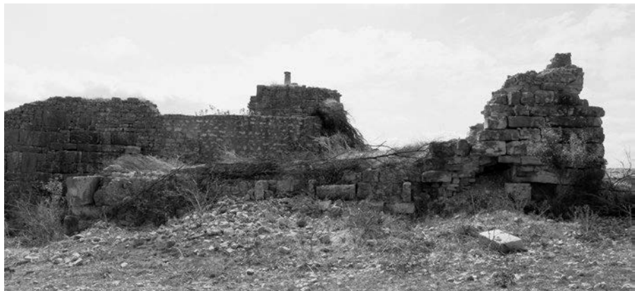
Abb. 370 Agbia. Turm A Nordseite
