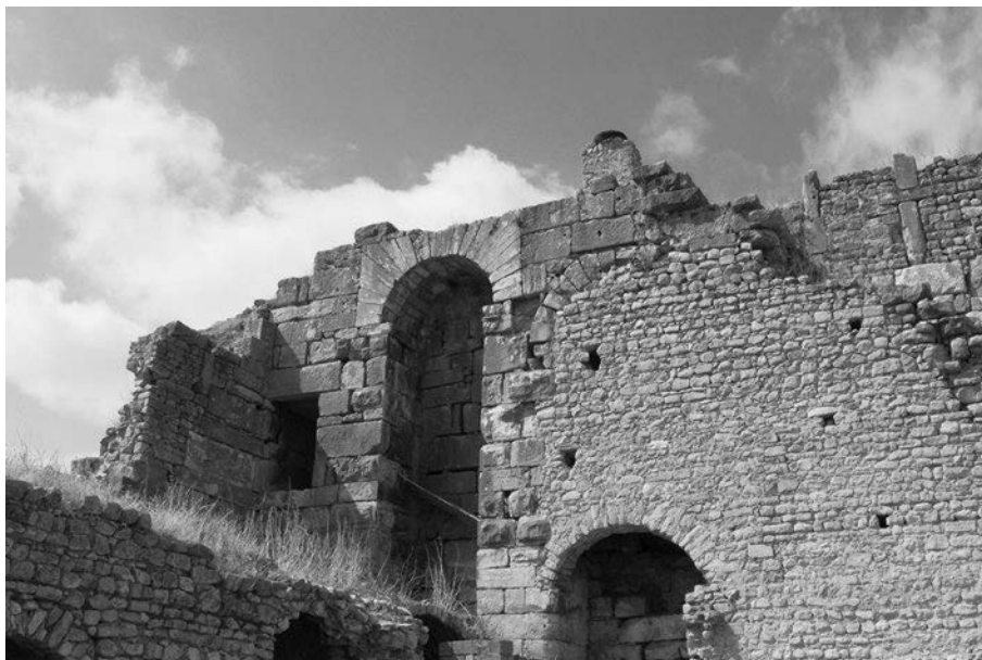
Abb. 380 Agbia. Turm D Innenseite mit Eingang und Entlastungsbogen
