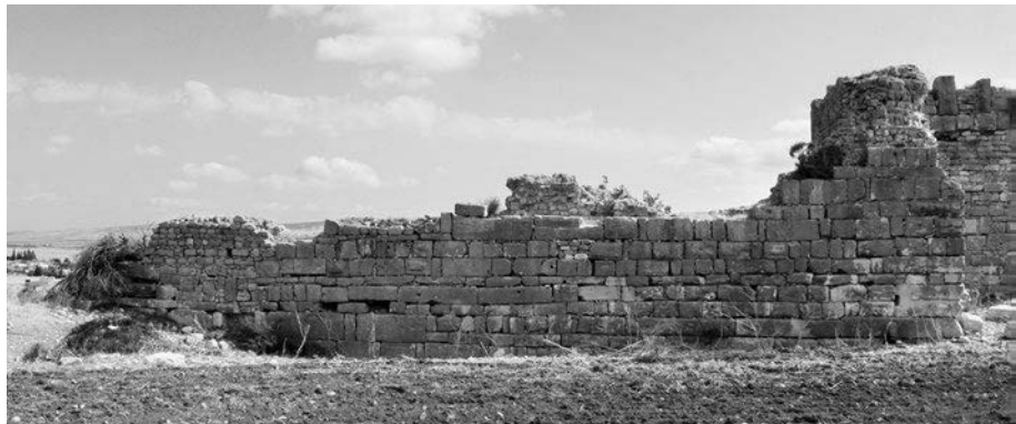
Abb. 350 Agbia. Außenseite der Westkurtine nördlicher Abschnitt
