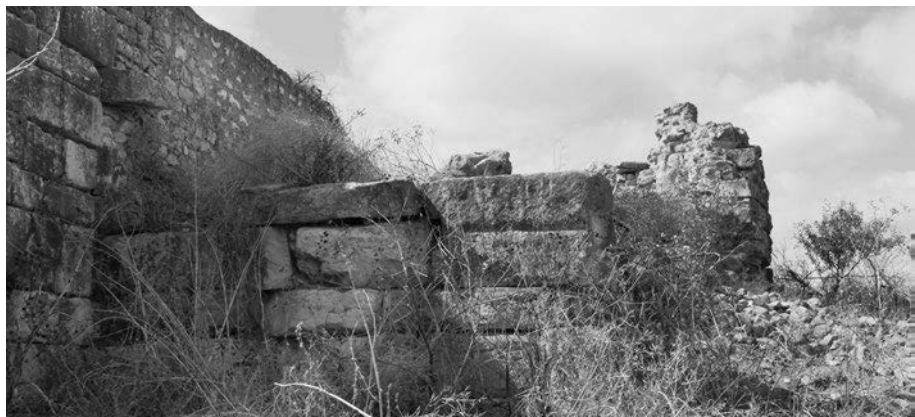
Abb. 371 Agbia. Turm A Ostseite
