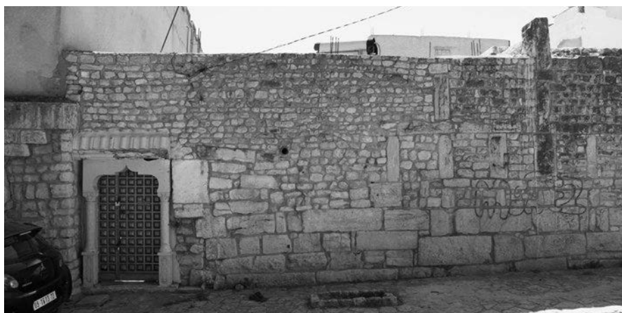
Abb. 393 Thubursicum Bure. Nordkurtine mit opus africanum -Mauerwerk und postbyzantinischem Mauerphasen
