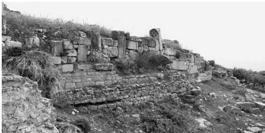
Abb. 427 Thugga. Außenseite der byzantinischen Stadtmauer südwestlich der Maison de Dionysos et d'Ulysse und dessen Terrassierungen
