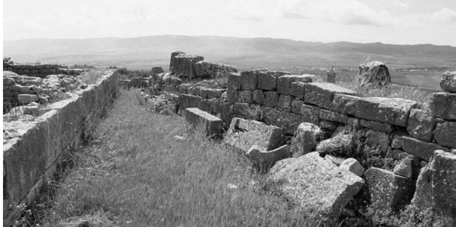
Abb. 426 Thugga. Innenschale der byzantinischen Stadtmauer im Hof h der Maison de Dionysos et d'Ulysse
