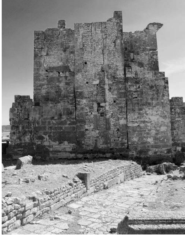
Abb. 171 Thugga. Nordkurtine Detailansicht der Rückwand des Kapitols
