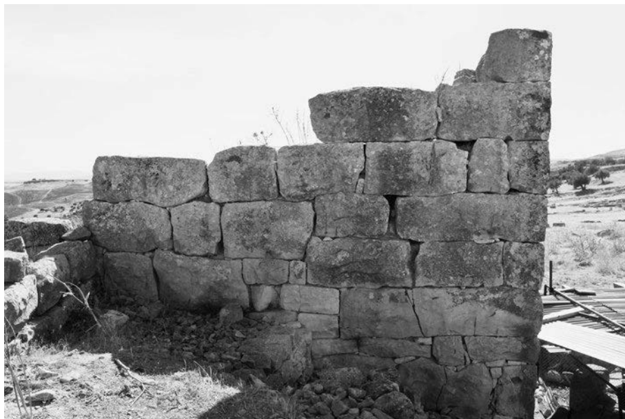
Abb. 411 Thugga. Stadtmauer Nordseite des vorrömischen Turms A
