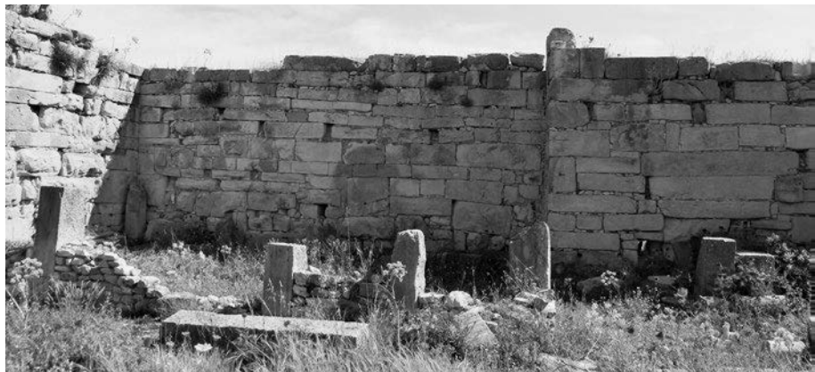
Abb. 280 Mustis. Gebäude D in der Nordecke der Festung
