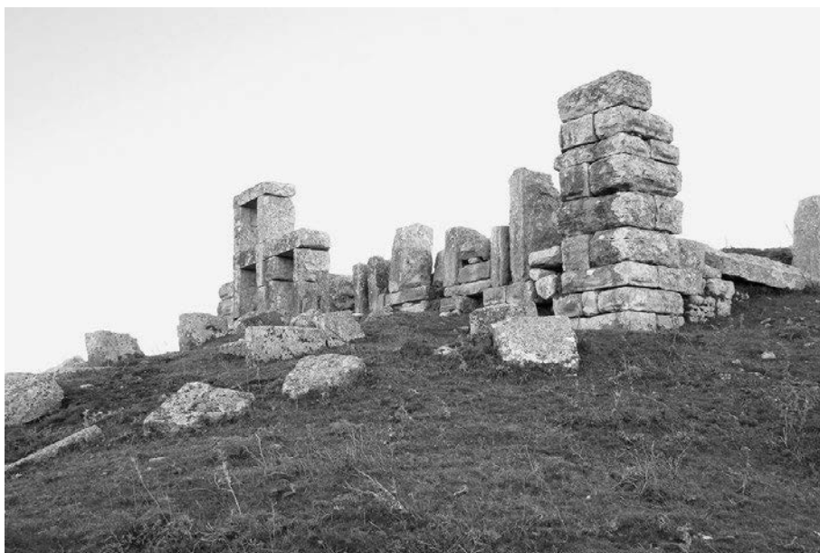
Abb. 478 Ain Melliti. Opus africanum -Mauerwerk mit Buckelquadern an der Nordostecke
