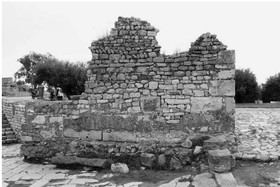
Abb. 418 Thugga. Abschnitt der byzantinischen Stadtmauer südlich des Theaters
