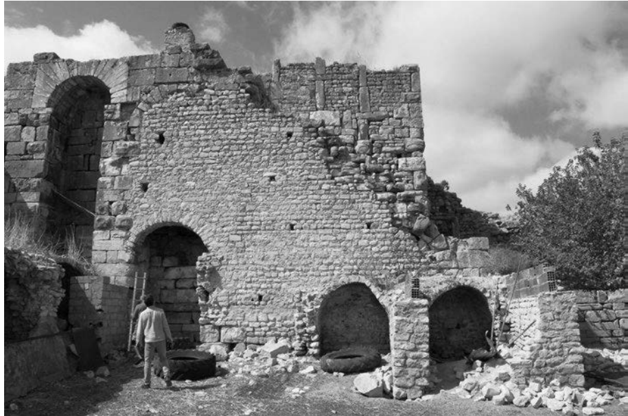
Abb. 354 Agbia. Innenseite der Westkurtine südlicher Abschnitt
