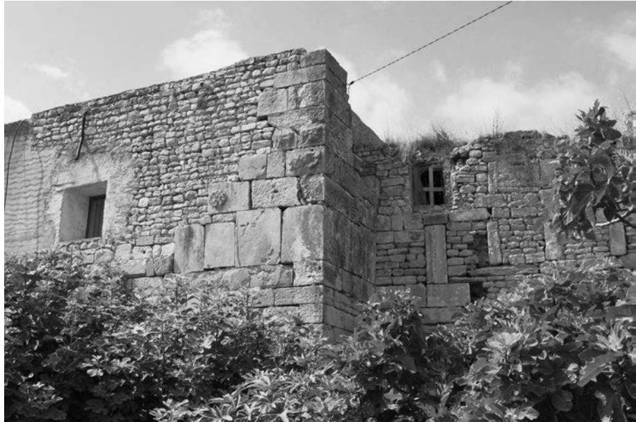
Abb. 378 Agbia. Turm C Eckverband mit Spolien
