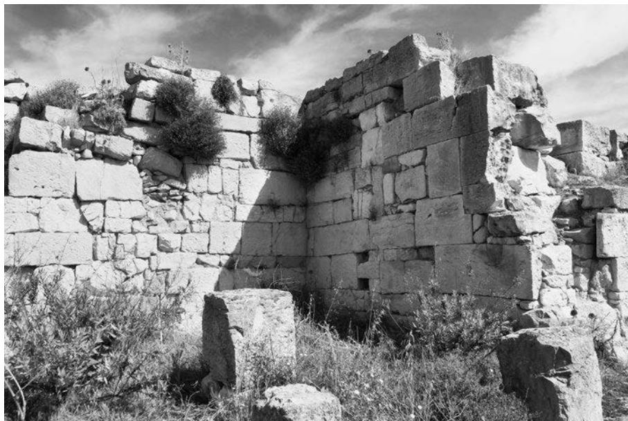
Abb. 266 Mustis. Östliche Hälfte von Bereich B4 mit der Innenschale der umknickenden Nordwestkurtine
