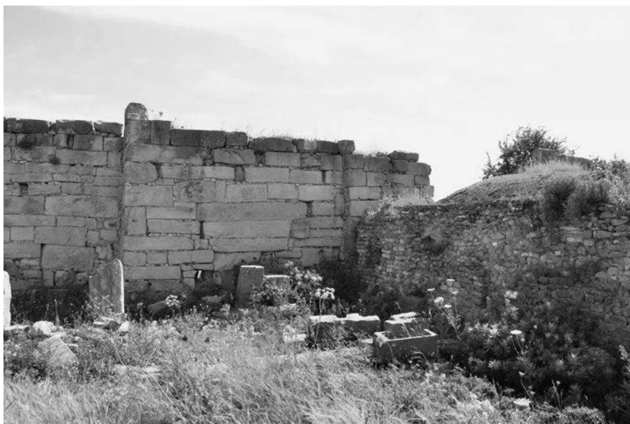
Abb. 281 Mustis. Bereich zwischen Gebäude D und den kaiserzeitlichen Zisternen
