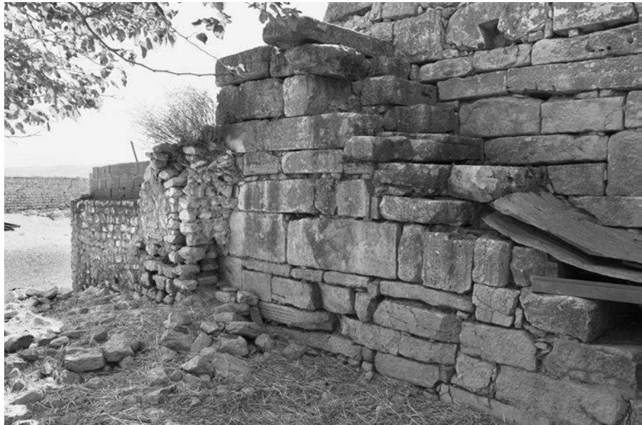
Abb. 351 Agbia. Treppe an der Innenseite der Westkurtine
