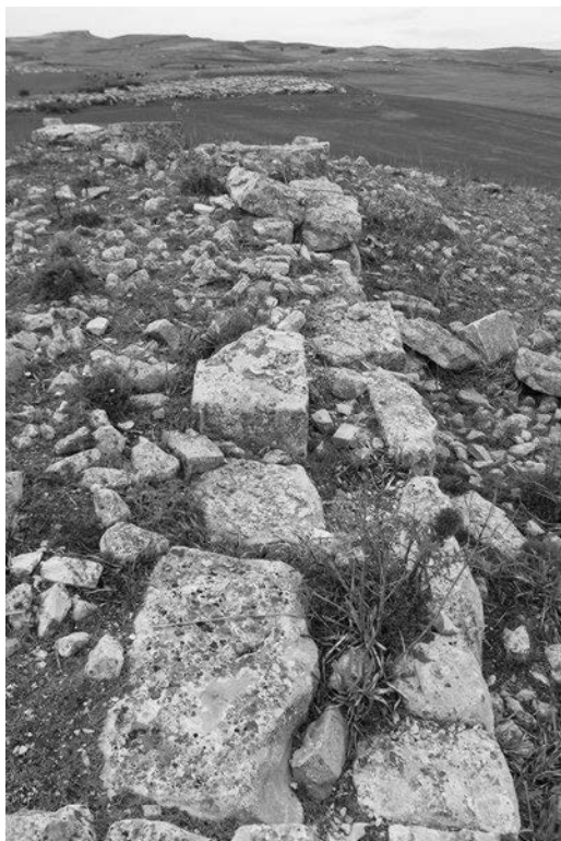
Abb. 482 Henchir er-Rebaa/Henchir Bel-Anine. Zweischaliges Mauerwerk an der Westseite der Befestigung
