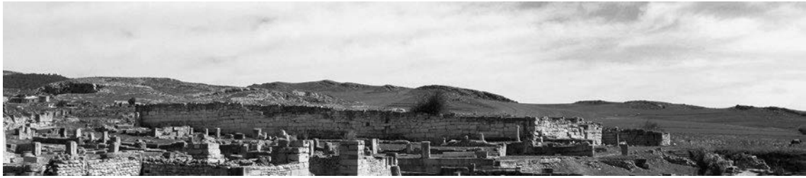
Abb. 221 Mustis. Gesamtansicht der Südwestkurtine
