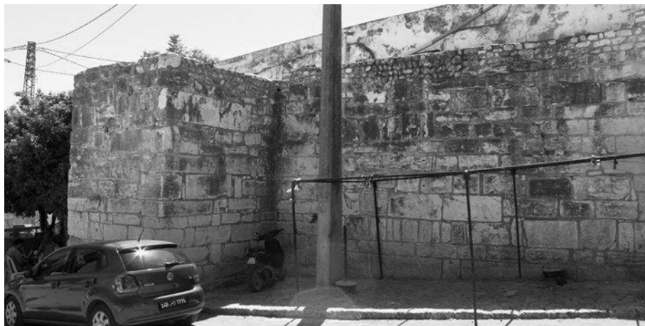
Abb. 396 Thubursicum Bure. Nordkurtine Abschnitt westlich von Turm C
