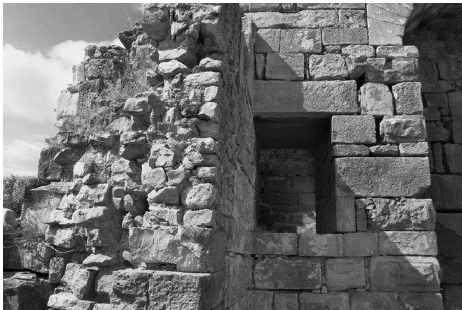
Abb. 384 Agbia. Turm D nach Osten gerichteter Eingang zum ersten Geschoss
