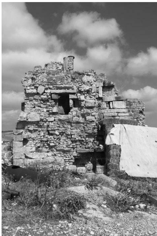
Abb. 386 Agbia. Turm D Südfassade mit Fensteröffnung
