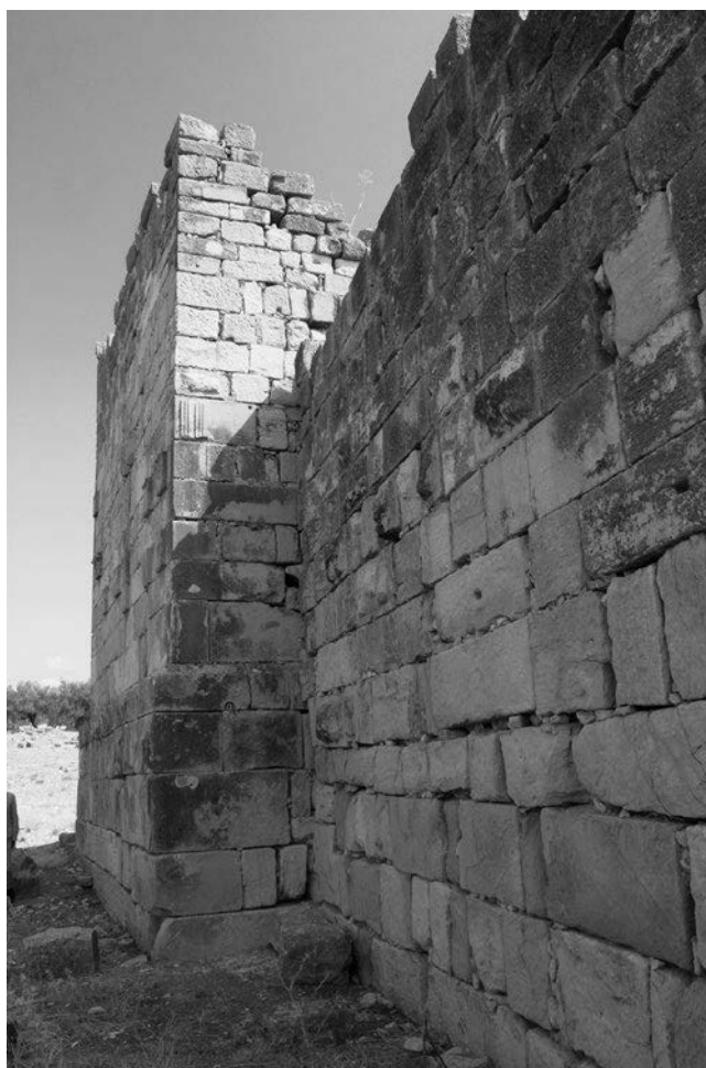
Abb. 320 Thignica. Äußere Westseite des Nordostturm B mit Sockelelement
