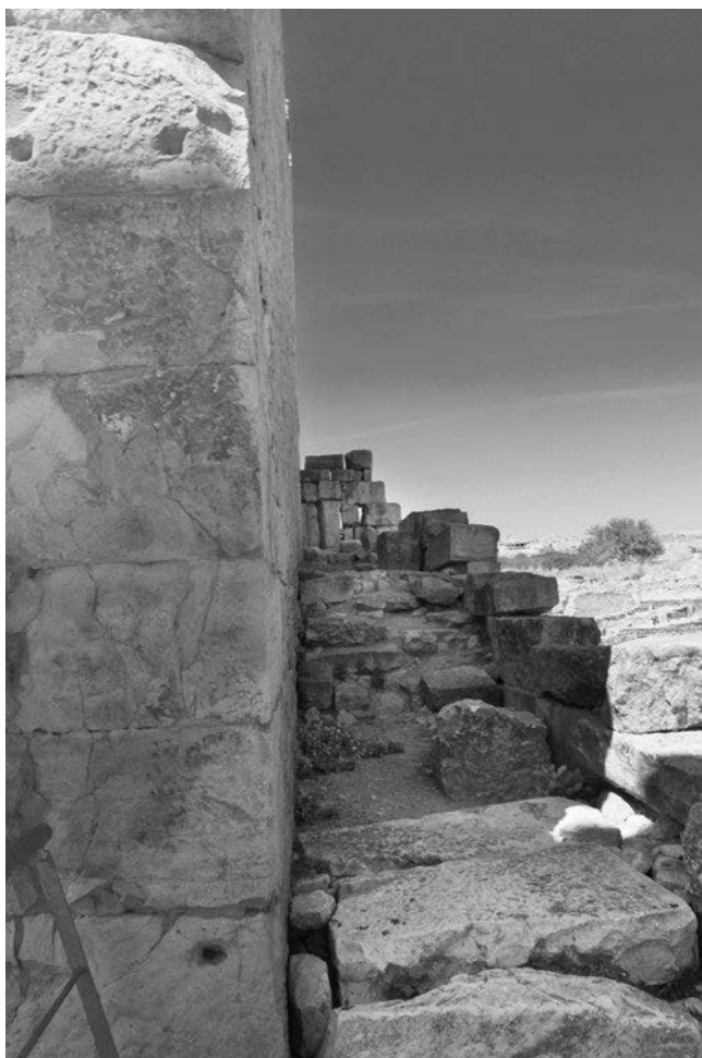
Abb. 182 Thugga. Einschalige Ummantelung des Kapitols an der Ostseite
