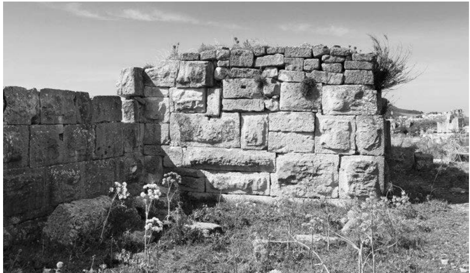
Abb. 228 Mustis. Nordwestkurtine Detailansicht des Bossenmauerwerks
