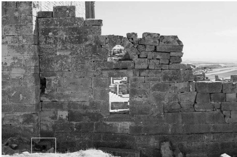
Abb. 193 Thugga. Ausfalltor B von Norden mit Wasserkanalöffnung
