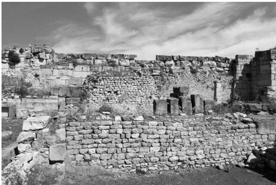
Abb. 276 Mustis. Reste eines kaiserzeitlichen Vorgängerbaus an der Südostwand von Raum C3
