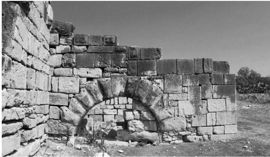
Abb. 306 Thignica. Westseite des Torturms D mit äußerem Tor
