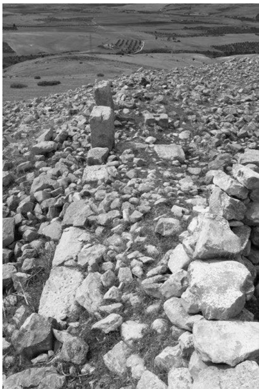
Abb. 460 Glia. Doppelschalige Befestigungsmauer direkt östlich des Tors an der Südseite
