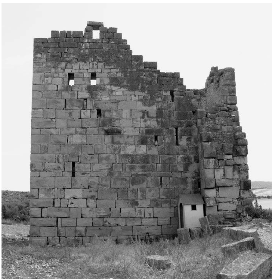
Abb. 322 Thignica. Nordseite Turm C
