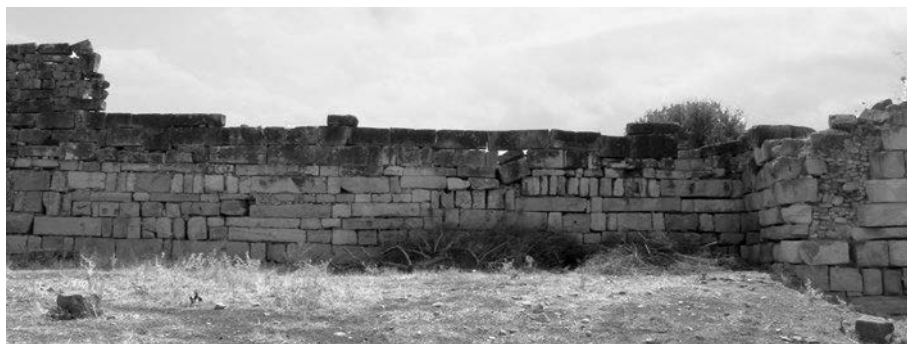
Abb. 294 Thignica. Westliches Drittel der Nordkurtine
