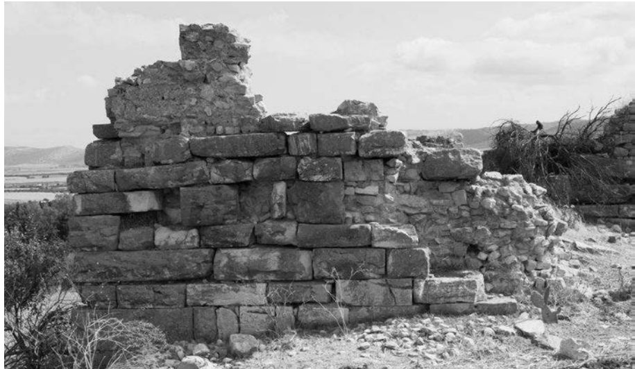
Abb. 369 Agbia. Turm A Westseite
