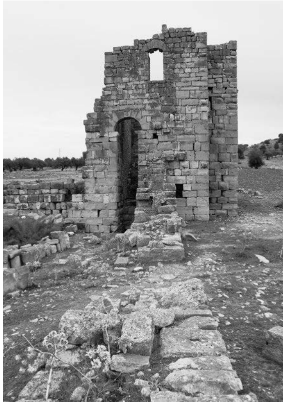
Abb. 284 Thignica. Östlicher Abschnitt der Südkurtine bei Turm C
