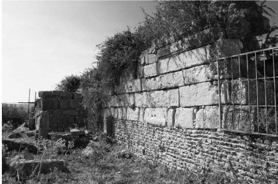
Abb. 233 Mustis. Detailansicht des mittleren Kurtinenabschnittes
