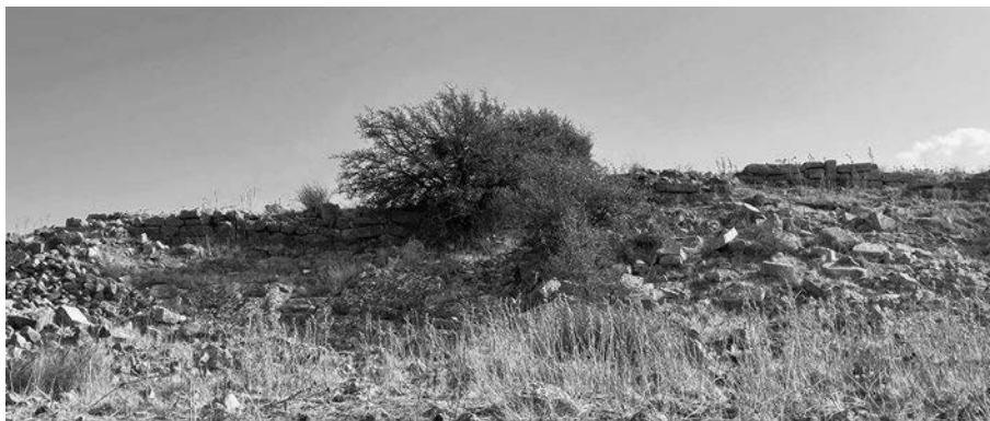
Abb. 455 Susti. Nördliche Außenseite der Doppelschalenmauer
