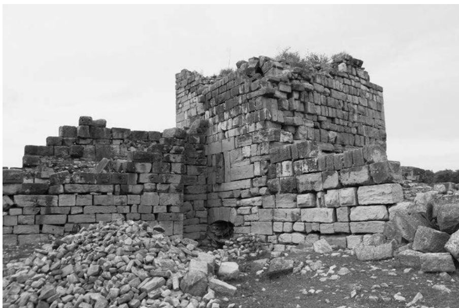
Abb. 321 Thignica. Innenseite von Turm B mit Eingang und Schießscharte von Südwesten
