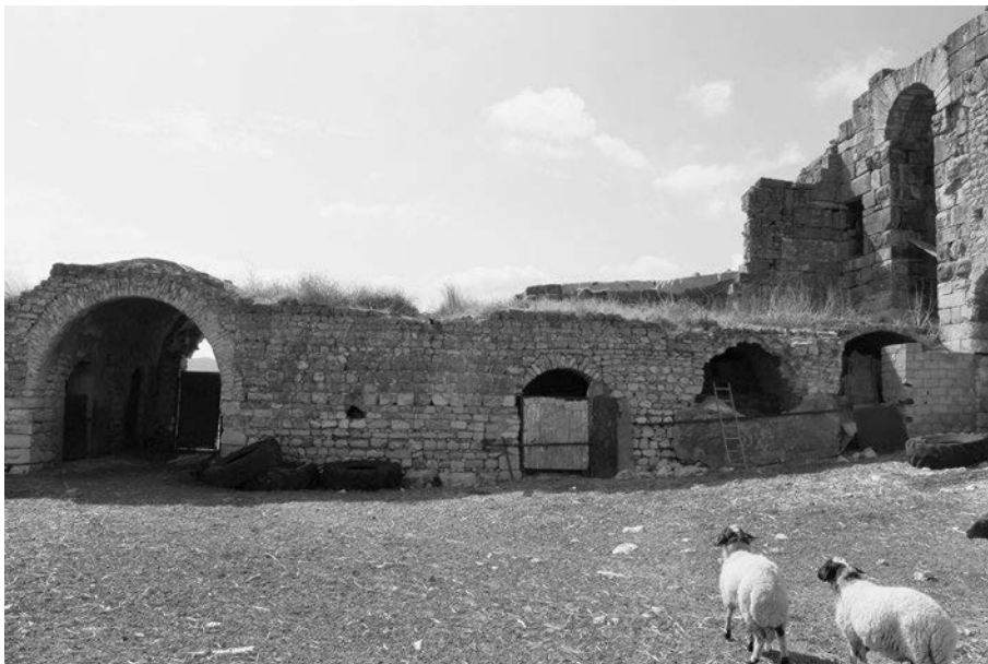
Abb. 344 Agbia. Südkurtine Innenseite aus der neuzeitlichen Nutzungsphase Westhälfte
