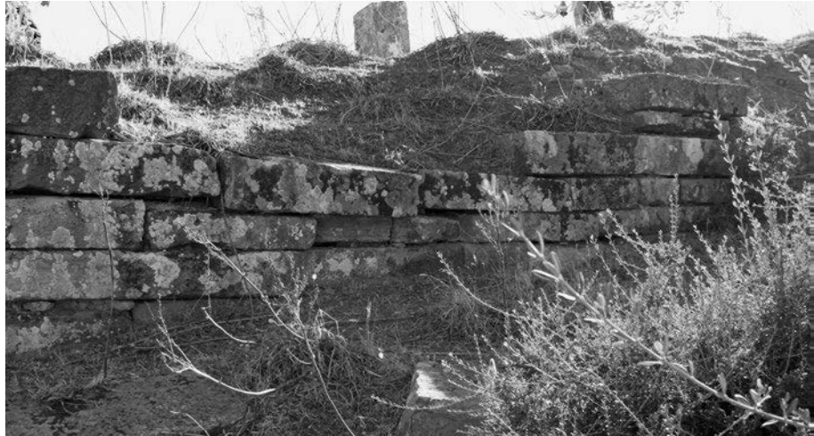
Abb. 432 Uchi Maius. Ansicht der noch erhaltenen Mauerlagen der Stadtmauer an der Nordseite
