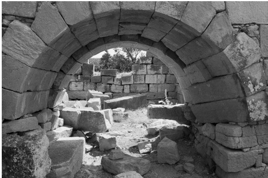
Abb. 311 Thignica. Nordseite des Torturms D mit wiederverwendetem Tonnengewölbe
