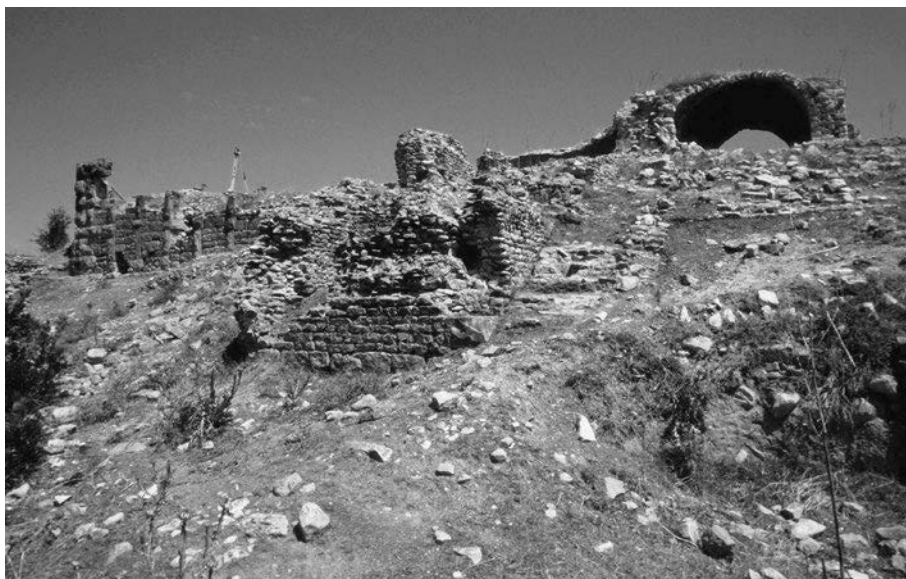
Abb. 488 Henchir el Bordj. Vermutlicher kaiserzeitlicher Turmbau an der Südfassade
