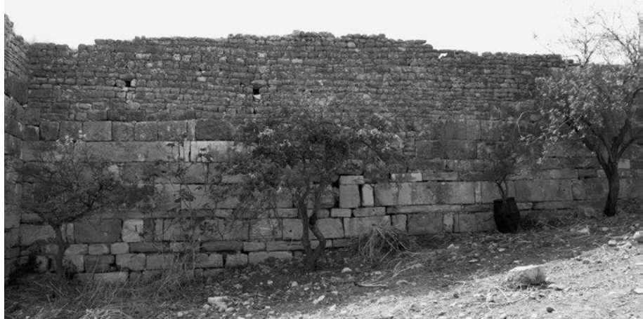
Abb. 359 Agbia. Nordkurtine Osthälfte mit byzantinischem und neuzeitlichem Mauerwerk
