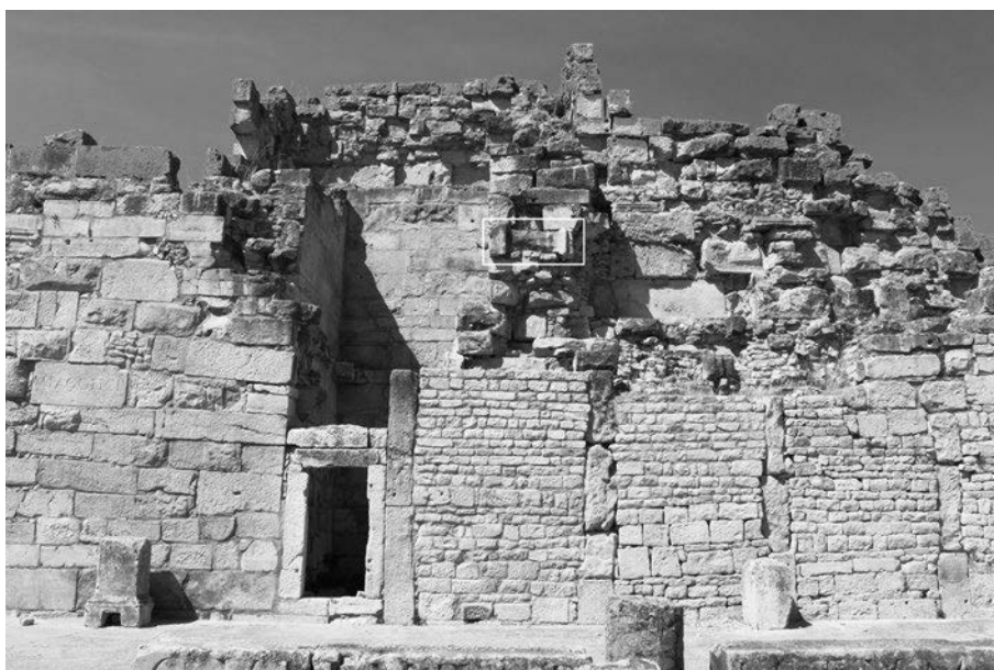
Abb. 195 Thugga. Südfassade von Nordturm A mit Tür und spoliertes Grabstele
