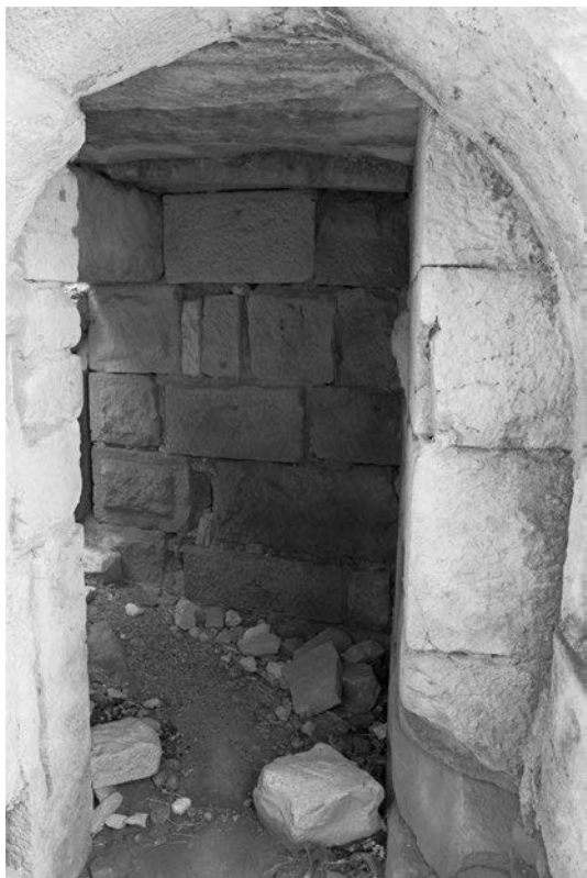
Abb. 325 Thignica. Abnickender Zugang zum Erdgeschoss von Turm C
