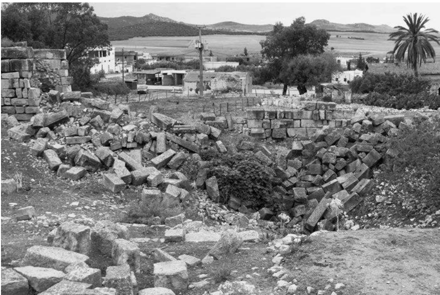
Abb. 292 Thignica. Kollabierte Mauer im Inneren der Festung mit Architekturspolien
