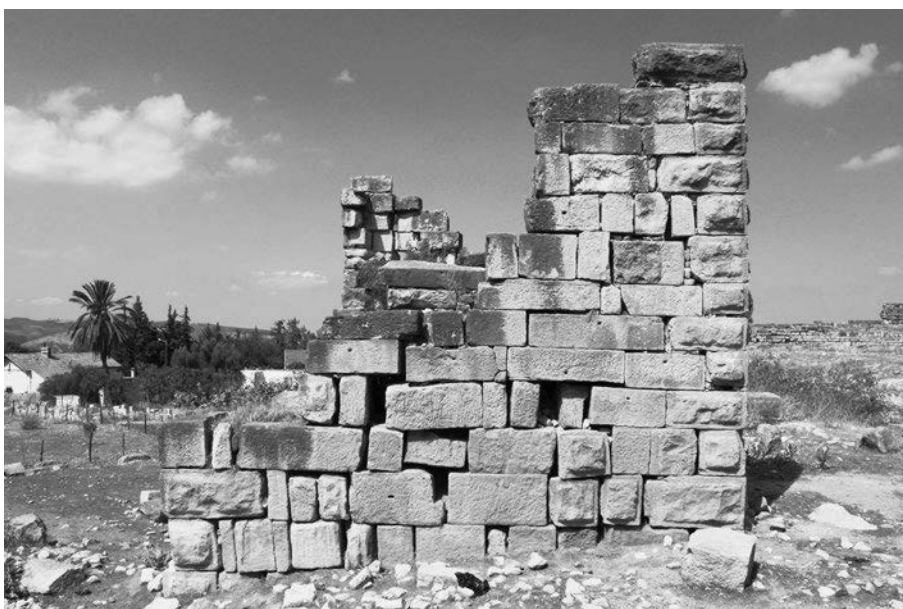
Abb. 335 Thignica. Turm E Südseite
