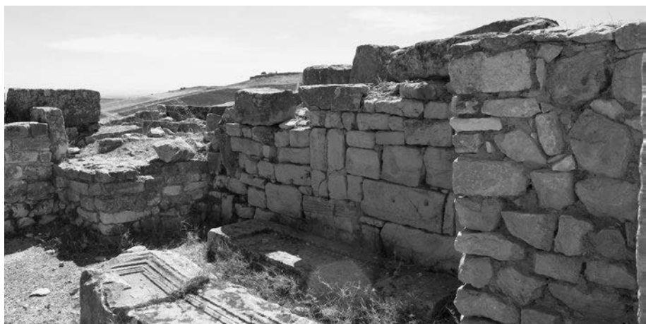
Abb. 202 Thugga. Südturm D Erdgeschoss Westmauer
