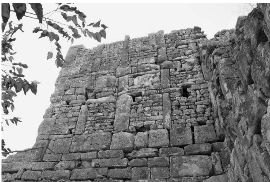
Abb. 353 Agbia. Kassetten des opus africanum-Mauerwerks an der Innenseite der Westkurtine
