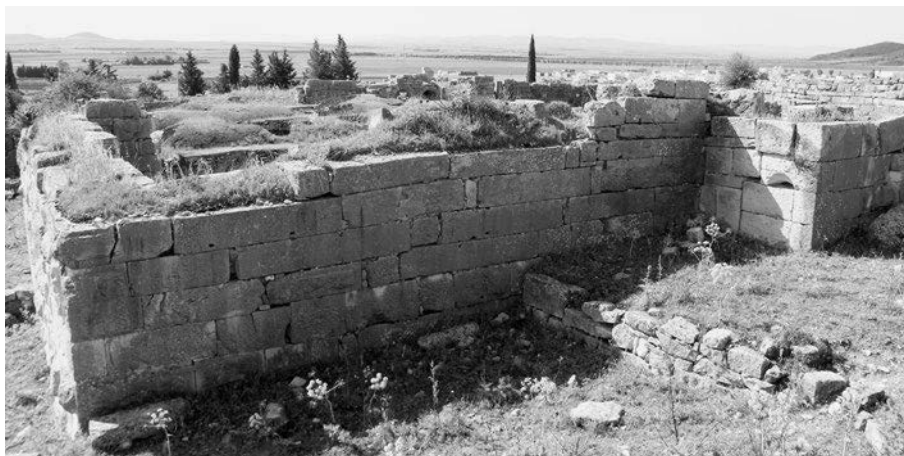
Abb. 230 Mustis. Nördlicher Abschnitt der Nordwestkurtine mit Spolienmauerwerk
