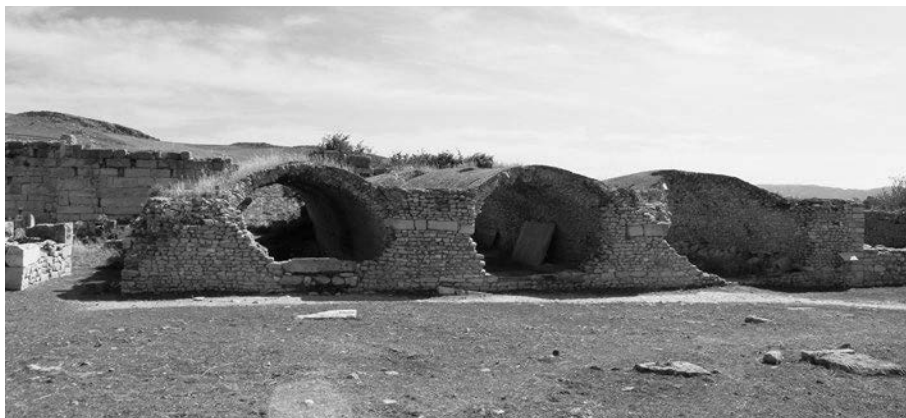
Abb. 245 Mustis. Kaiserzeitlicher Zisternenkomplex im Inneren der Festungsanlage
