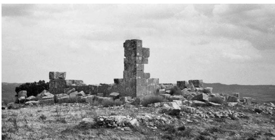
Abb. 415 Ansicht Turm DU061 von Südwesten
