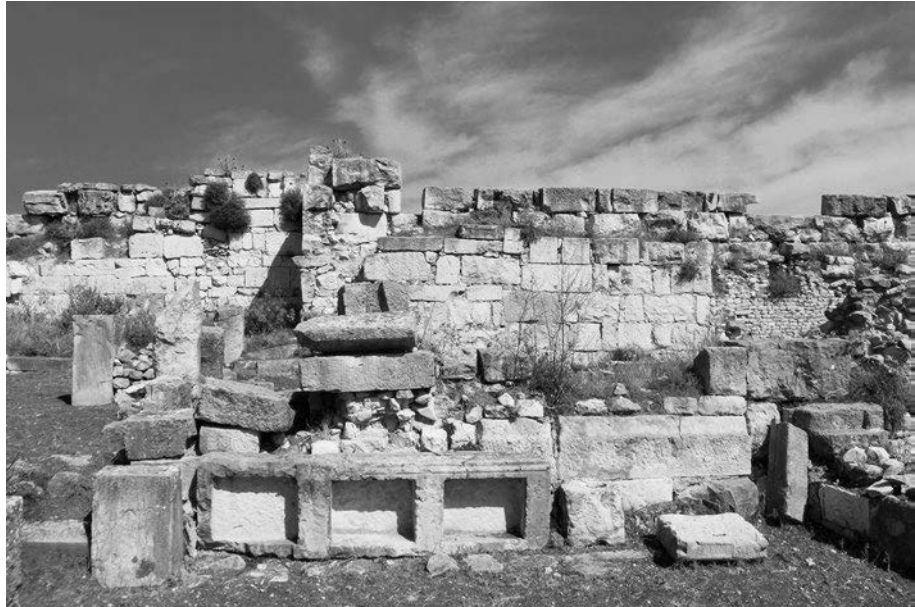
Abb. 274 Mustis. Außenseite der Südwestwand von Raum C2 mit Spolien
