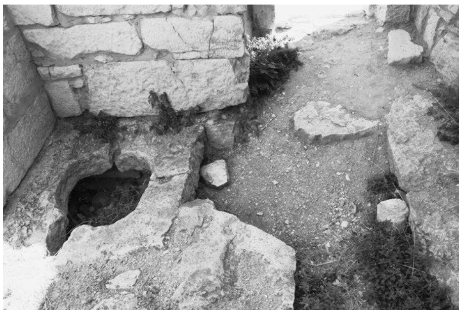
Abb. 197 Thugga. Erdgeschoss von Nordturm A mit Resten einer Latrine
