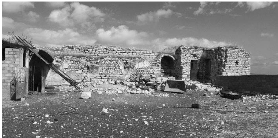
Abb. 361 Agbia. Innenseite der Nordkurtine mit Resten der Arkadenganges aus der Phase der Karawanserei
