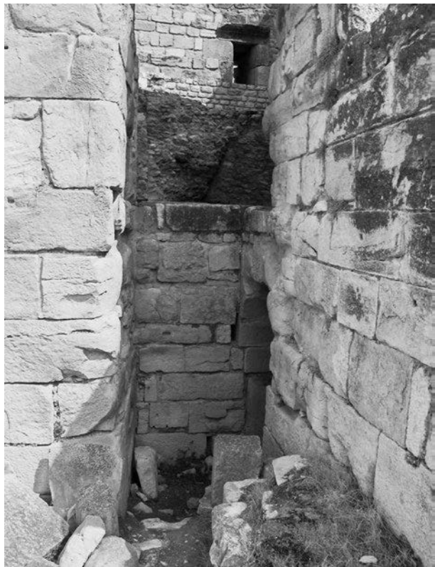
Abb. 324 Thignica. Zugang um Erdgeschoss von Turm C
