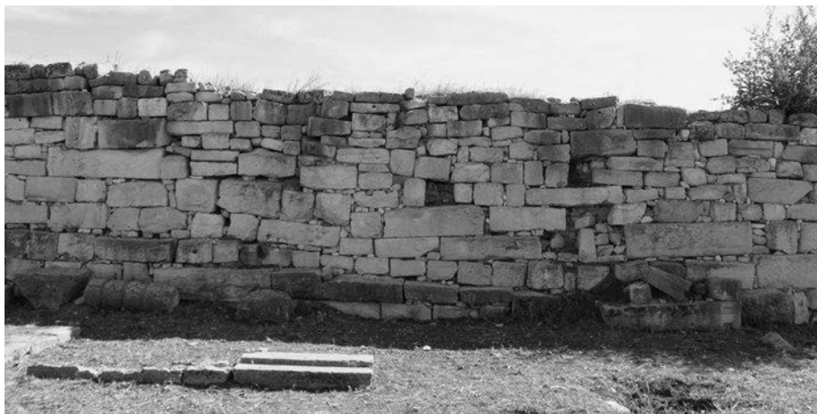
Abb. 224 Mustis. Fundament eines kaiserzeitlichen Forumsbau an der Südwestkurtine
