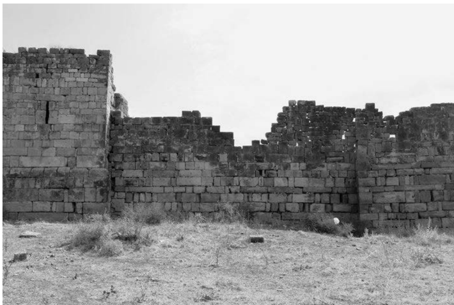
Abb. 297 Thignica. Nordkurtine mit Turm B in der Nordostecke der Festung
