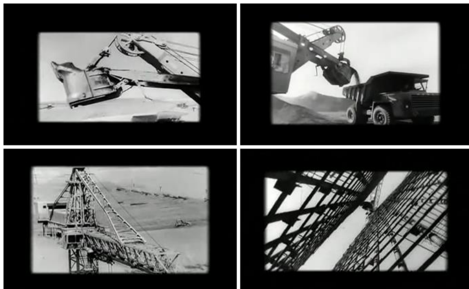
Abb. (57) Situation B: Aufbauarbeiten des Euphrat-Damms (Film: Flut im Ba'ath's Land 2003)
