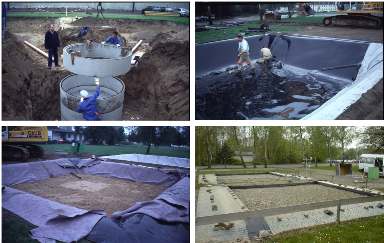
Abbildung 8: Aufgenommene Bilder während und nach Abschluss des Baus der Testfelder (oben links: Installation des Sammelschachtes; oben rechts: Verlegung der HDPE-Folie; unten links: Einbau der Kies-Schicht (0-32 mm \emptyset ); unten rechts: Zustand der Testfelder nach Abschluss der Bauarbeiten)
