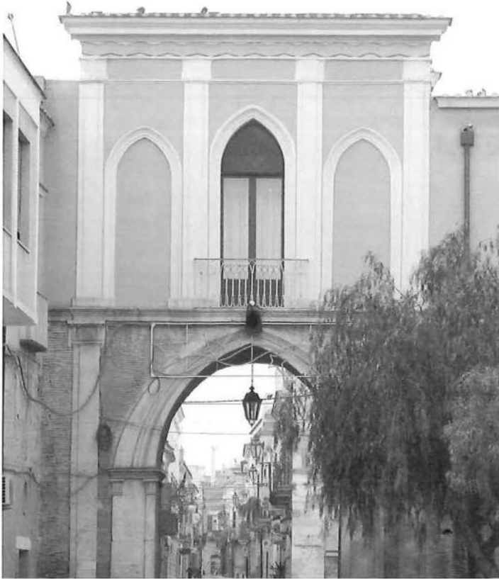
Abb. 9: Lucera. Porta Foggia mit spätmittelalterlicher Bausubstanz..
