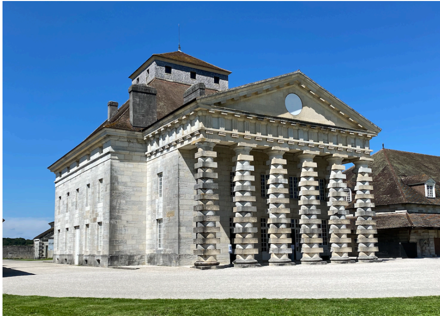
Abbildung 13: Frontansicht der Maison du Directeur (eigene Aufnahme)
