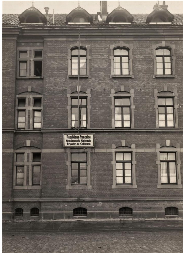
Abbildung 2: Von den Franzosen genutzter Teil des Dikasterialgebäudes, 1925.
