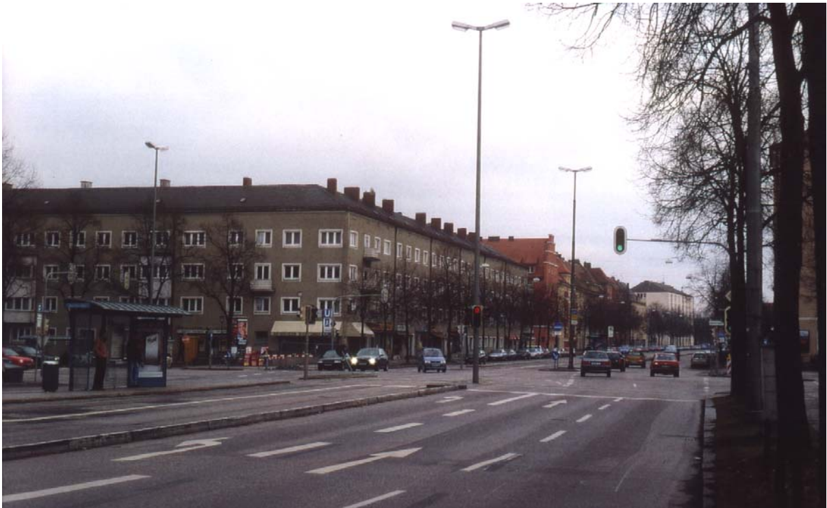
Abbildung 8-1: Die Busspur befindet sich auf den teilweise zuasphaltierten Straßenbahngleisen (siehe Bushaltestelle am linken Bildrand). Aufnahme im südlichen Abschnitt in der Rosenheimer Straße am Karl-Preis-Platz, Februar 2001.
