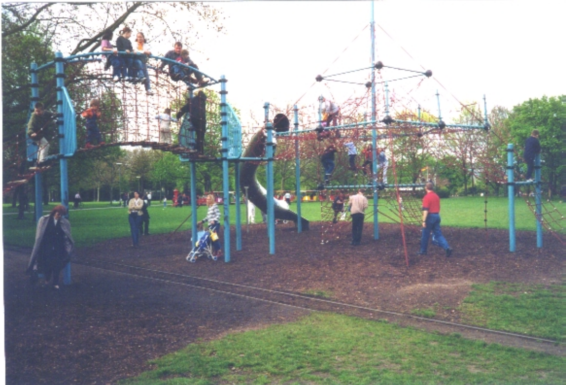
Abb. 18: Aus Stahlrohren und Seilen gebautes Klettergerüst im Volkspark
