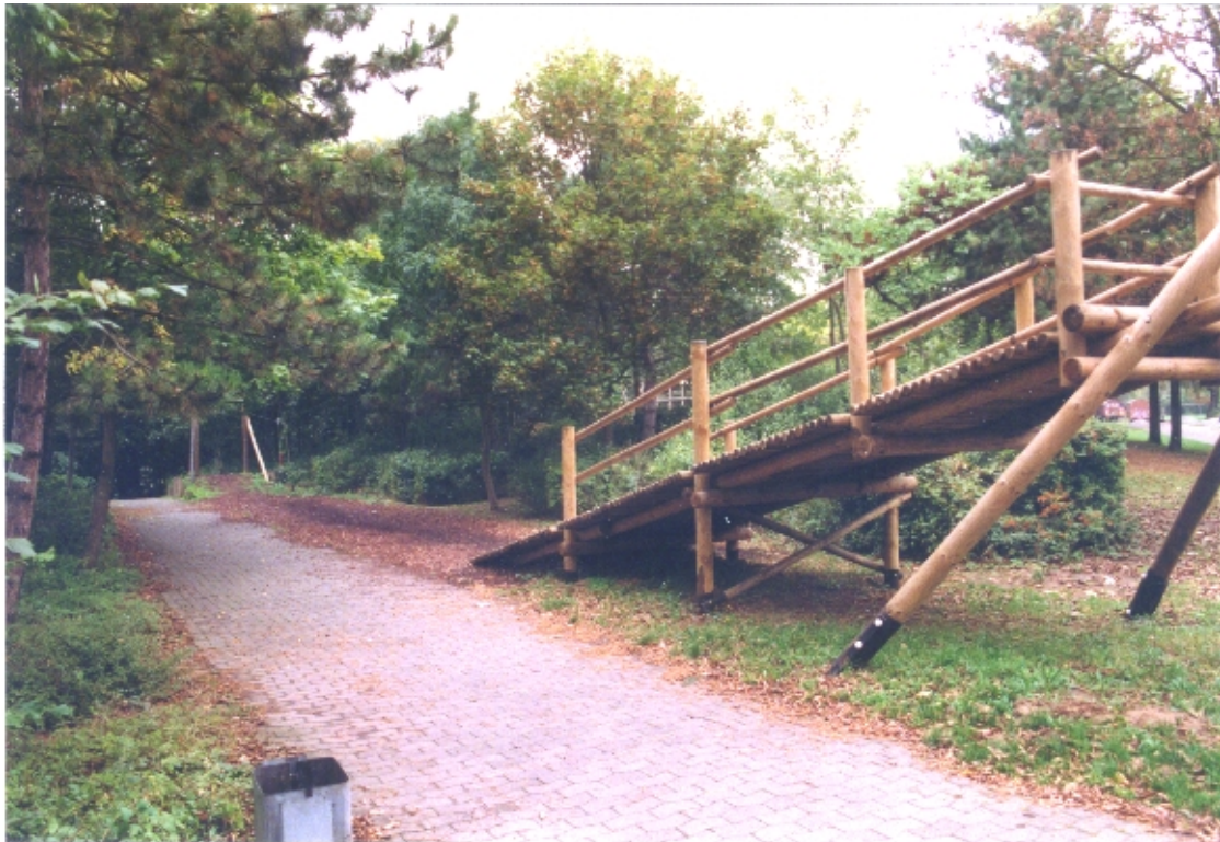
Abb. 30: Seilbahn aus Holz im südlichen Teil des Spielplatzes
