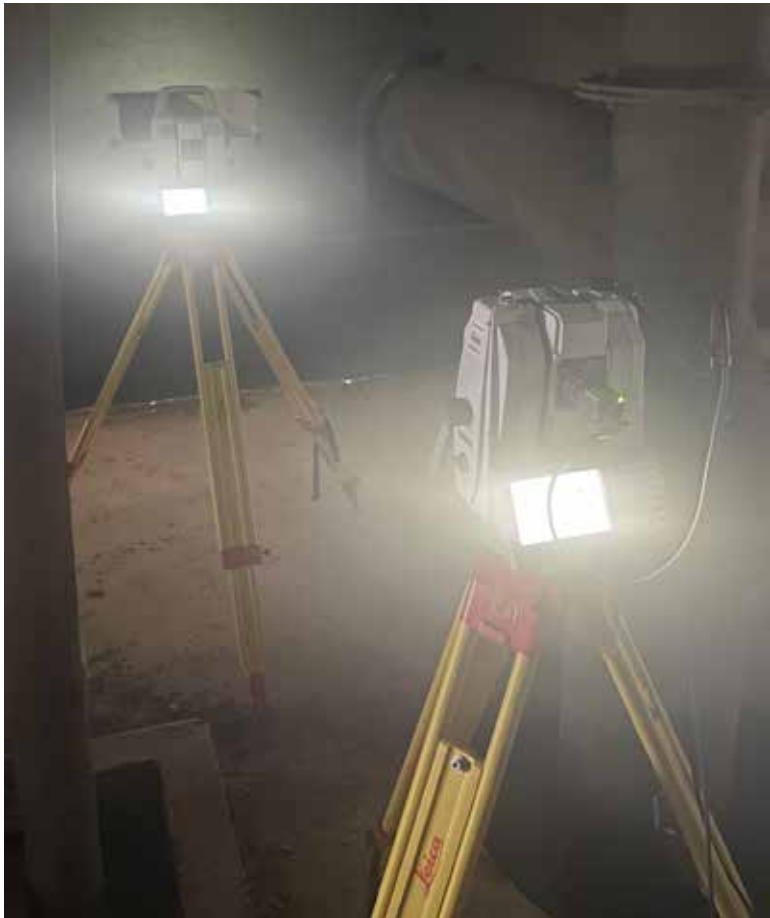
Foto oben Einsatz von MoDiTa 3.0 mit Leica MS60 im Hohlkasten der Südbrücke Koblenz. Foto: Sebastian Dessloch, CC BY SA 4.0
