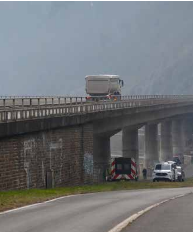
Abbildung oben: Erfassung vertikaler Bauwerksverschiebungen am Unkelsteinviadukt (Remagen) mittels terrestrischem Laserscanning im Rahmen von Belastungsversuchen Foto: Peter Steffens CC BY-SA 4.0.
