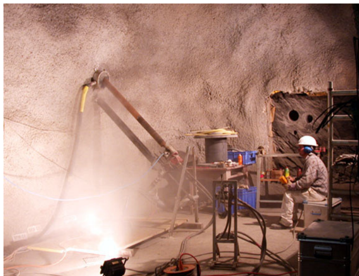
Abb. 43: Erstellung einer Bohrung im Opalinuston (Mont Terri, Schweiz) [BGR]
