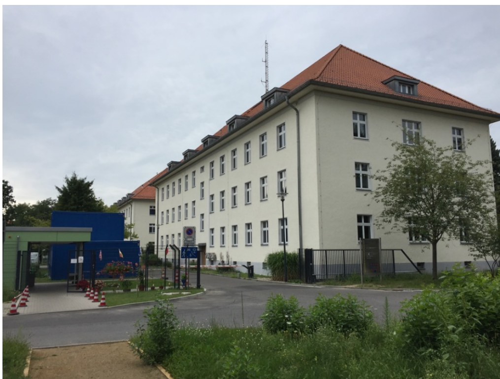
Abbildung 30: Außenansicht der EAE Wünsdorf (MÜCKE 2016)
