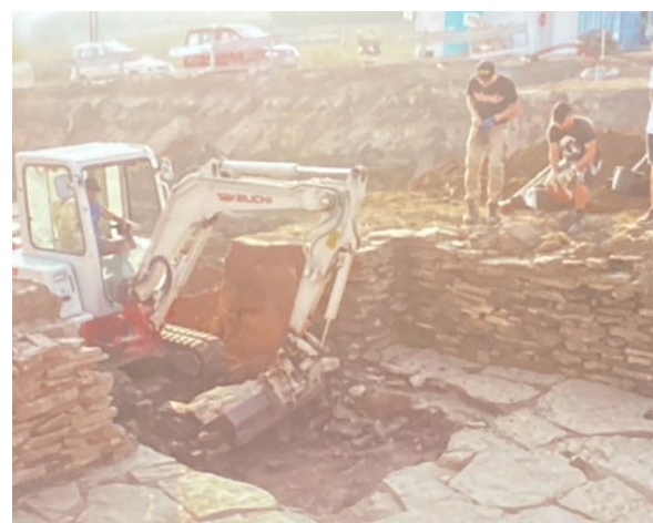
Abb. 16: Foto gezeigt während des Vortrags von Günter Brücken. Der möglicherweise planmäßig geräumte (?) Keller wurde zerstört und beseitigt.
