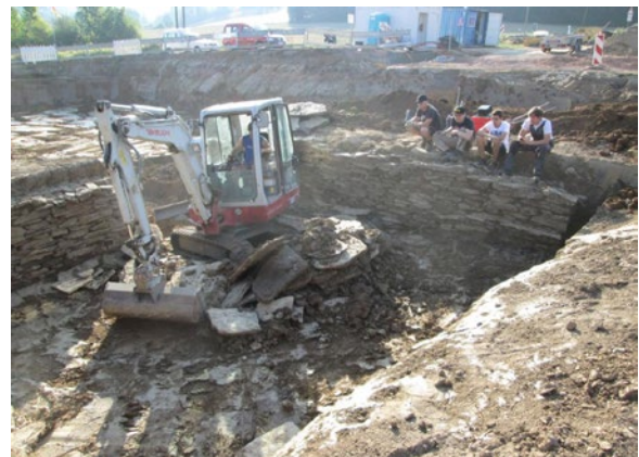
Abb. 14: Keller I mit Bagger. Ausstellung/Dokumentation Odernheim 2016.
