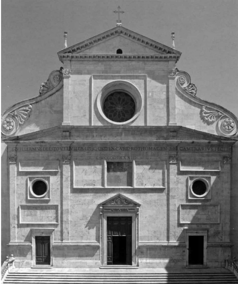
Abb. 6: Rom, Fassade der Kirche S. Agostino.
