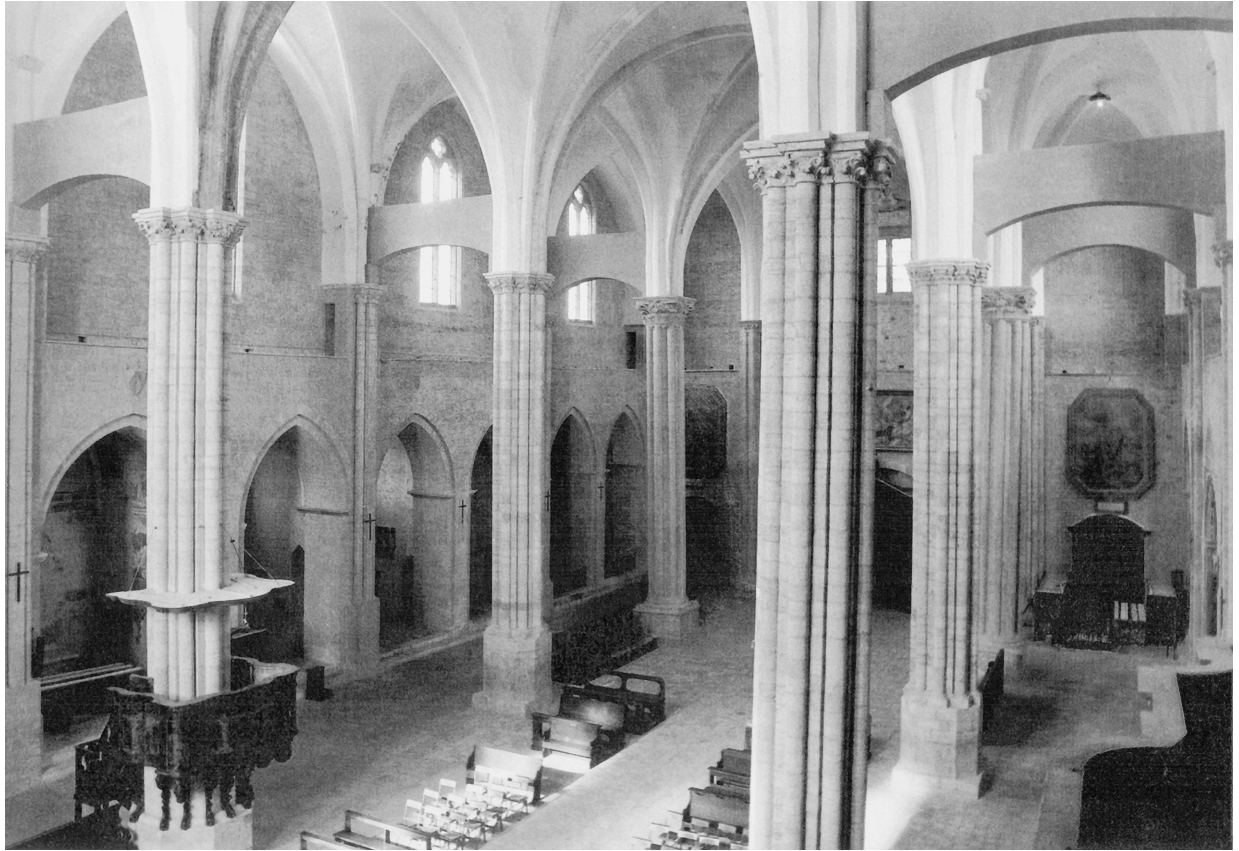
Abb. 8: Todi, S. Fortunato, Innenraum mit Blick zur Eingangswand
