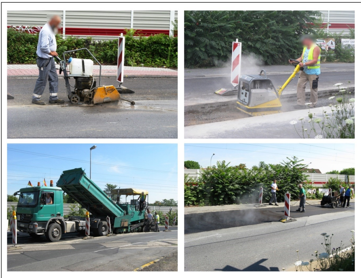
Abbildung 74: Einsatz von Asphaltmaschine (oben links) und Rüttelmaschine (oben rechts) im Straßenbau. Beladung eines Asphaltfertigers mit frischem Asphalt (unten links). Auftragung einer Bitumenemulsion auf die frische Asphaltbahn (unten rechts). Alle Personen und Firmenzeichen wurden zur Wahrung der Anonymität unkenntlich gemacht. (Fotos: P. Faber)
