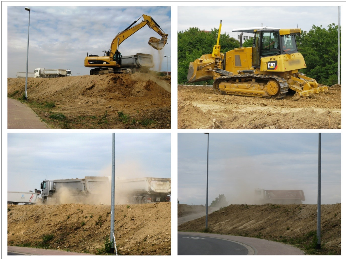
Abbildung 68: Aushub und Verladung von Erdmaterial mit einem Bagger sowie Abtransport des Aushubs durch mehrere LKW (oben links). Planierdrape zur Auflockerung des Untergrunds (oben rechts). Partikelemissionen durch das Befahren der unbefestigten Baupisten (unten links und rechts). (Fotos: P. Faber)
