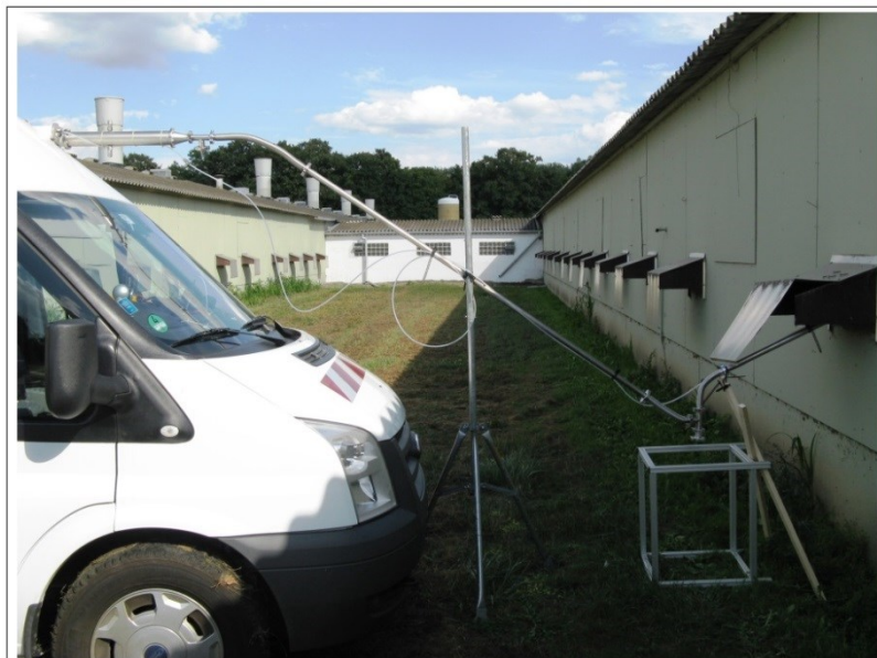
Abbildung A-3: Erweiterung des Fronteinlasssystems von Mola für die Messung der Aerosolpartikel im Stall einer Intensiv-Legehennenhaltung. (Foto: P. Faber)
