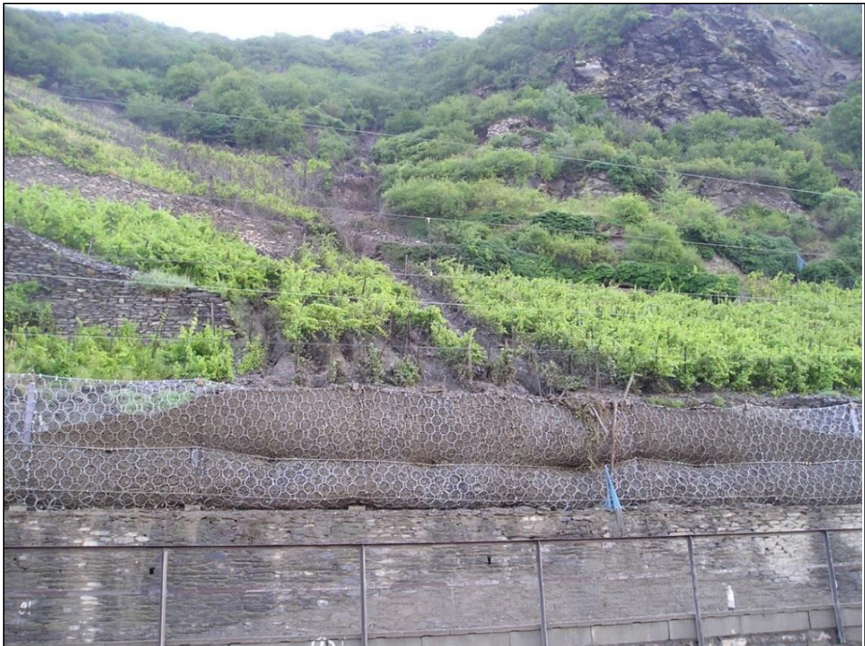
Abb. 46: Verfüllter Fangzaun bei Dörscheid in Folge eines konvektiven Starkregens (Foto: H.J. Matthesius 2005)
