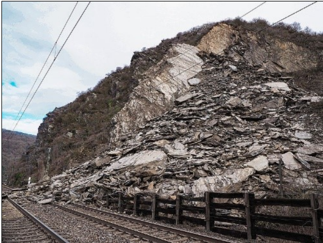
Abb. 39: Seitliche Ansicht des Felssturzes von Kestert vom 15.03.2021 (Foto: A. Wehinger 2021)
