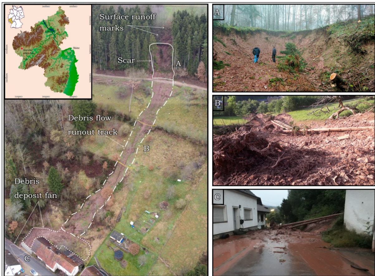
Abb. 98: Luftbild des Hangmure in Biersdorf am See vom 14.07.2021 (Aufnahme vom 02.02.2022). A Blick in den Abrissbereich. B Blick bergab auf die Auslaufstrecke. C Murgangsablagerungen auf der Gemeindestraße (Fotos: A. Weiler, aufgenommen am 15. Juli 2021, HAGGE-KUBAT et al. 2022)
