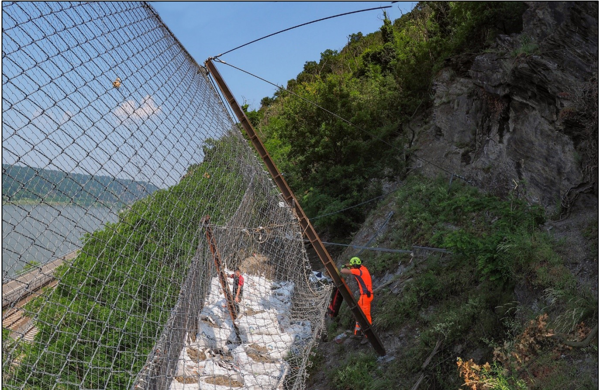
Anhang: E: Beispiel für einen Murgangsverbau bei Hönningen im Ahrtal (Foto: T. Hagge-Kubat 2023)
