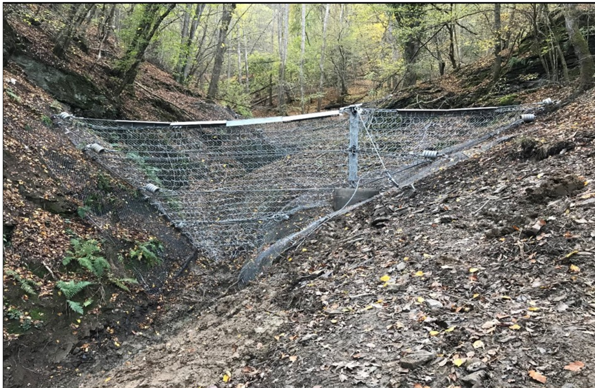
Anhang: E: Beispiel für einen Murgangsverbau bei Hönningen im Ahrtal (Foto: T. Hagge-Kubat 2023)
