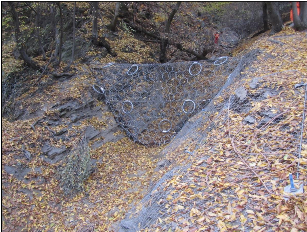
Abb. 45: Schutzzaun in einem Murgangserinne bei Sankt Goar-Werlau (Foto: H.J. Matthesius 2011)
