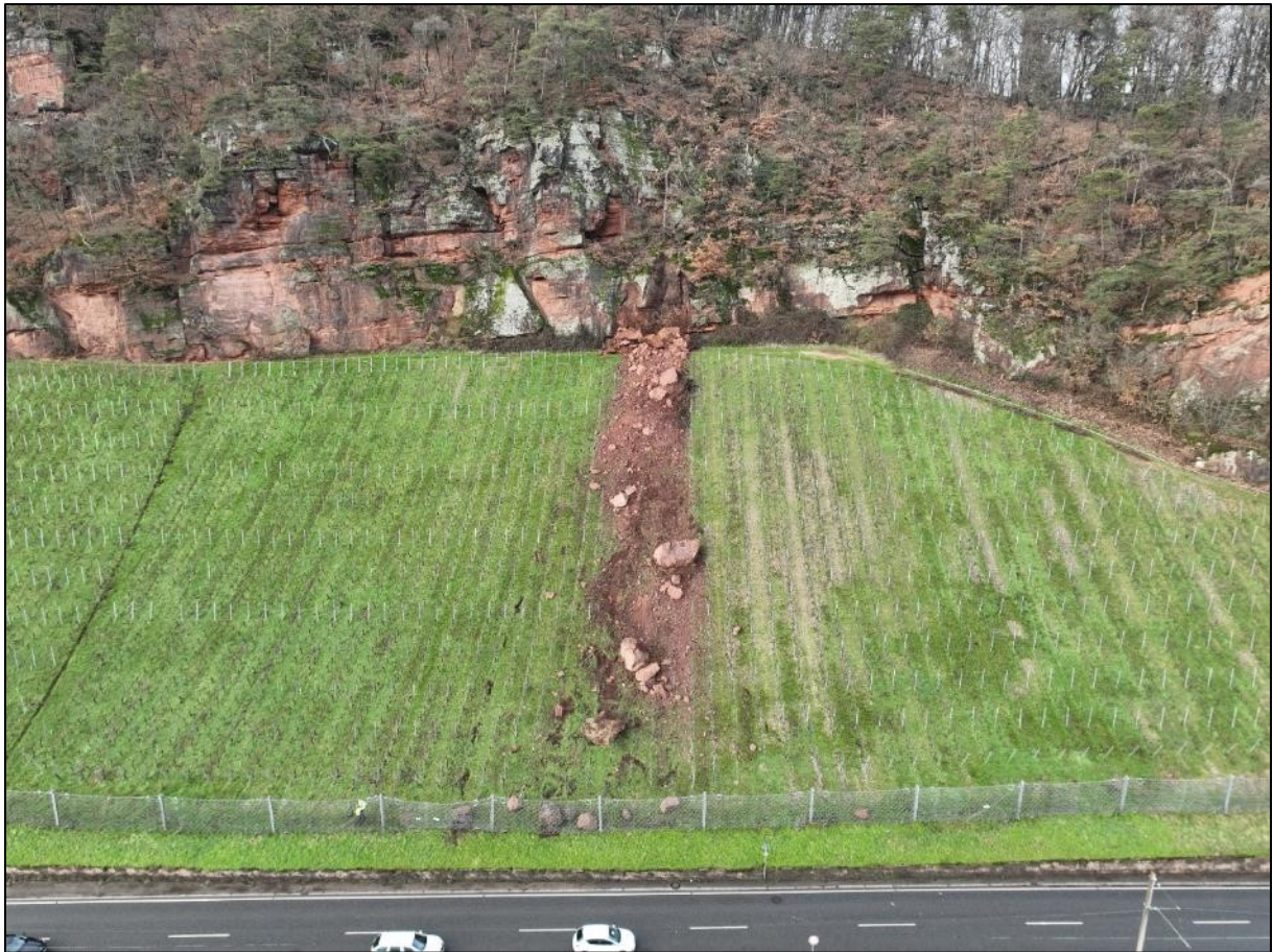
Abb. 40: Drohnenaufnahme des Felssturzes vom 25.01.2023 am Trierer Augenscheiner (Foto: T. Hagge-Kubat 2023)
