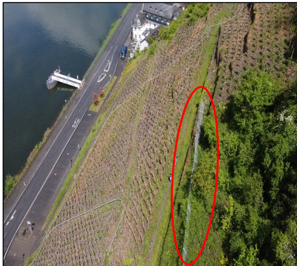
Abb. 79: Drohnenaufnahme des Westhangs des Burgbergs mit hervorgehobenem Steinschlagfangzaun auf halber Hanghöhe (HAGGE-KUBAT et al. 2021)
