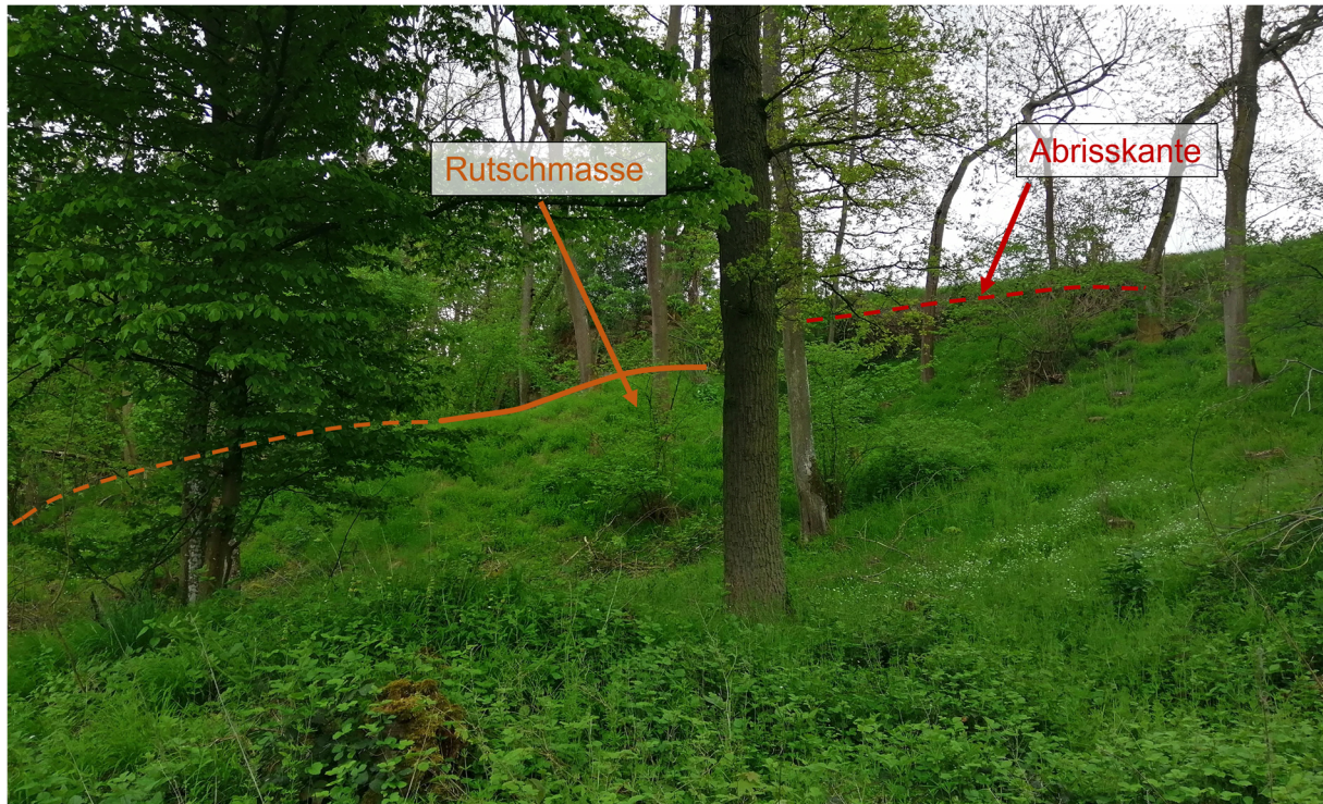
Abbildung 26: Foto einer Rutschung in einem bewaldeten Gebiet. Gut zu erkennen sind die Abrisskante sowie die Rutschmasse. Die Wulst konnte im Gelände auch erkannt werden ist jedoch im Bild nicht zu erkennen.
