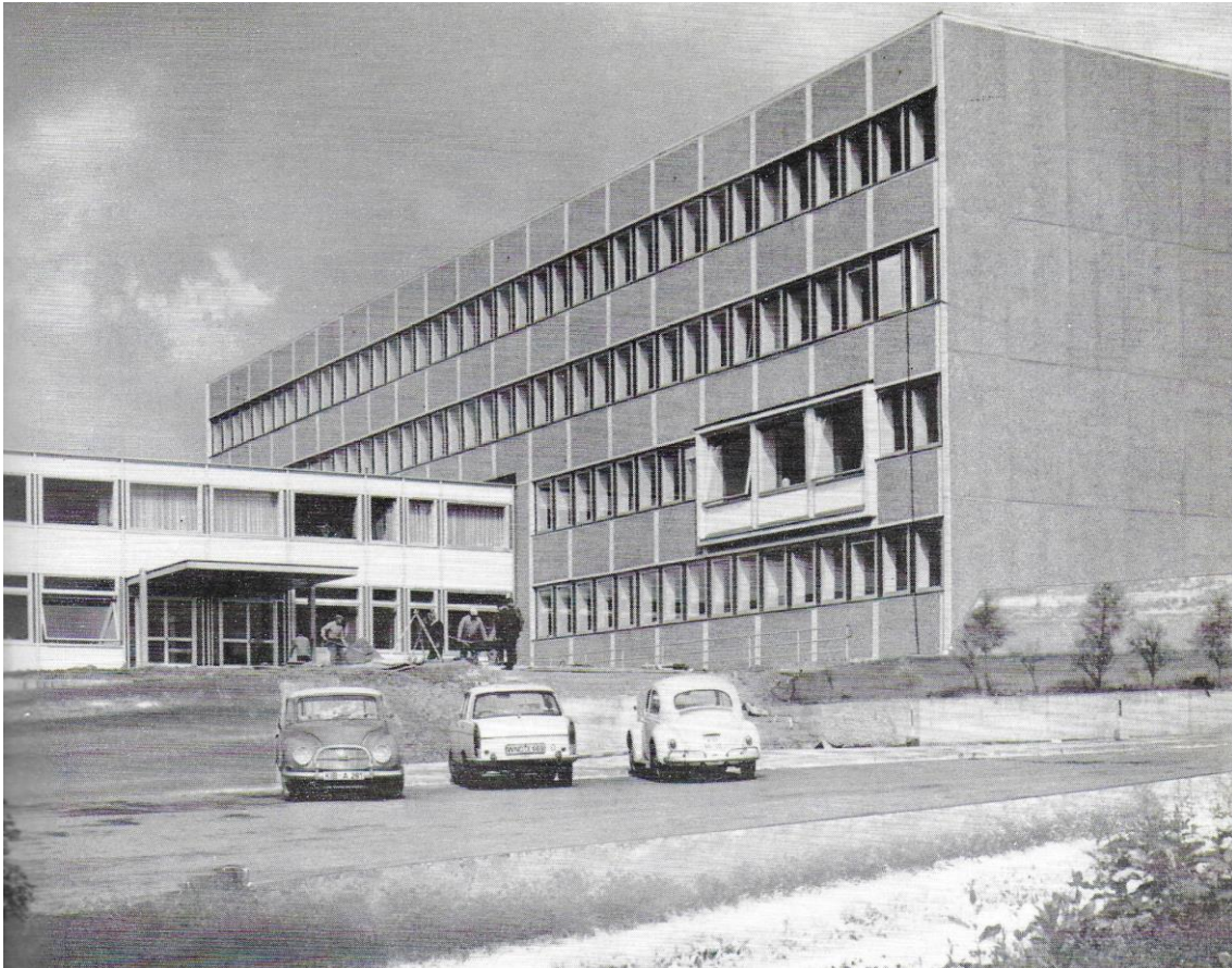
Abb. 3: Der Neubau des Gymnasiums wurde 1965 feierlich eröffnet (Quelle: Verein NPG 1965)
