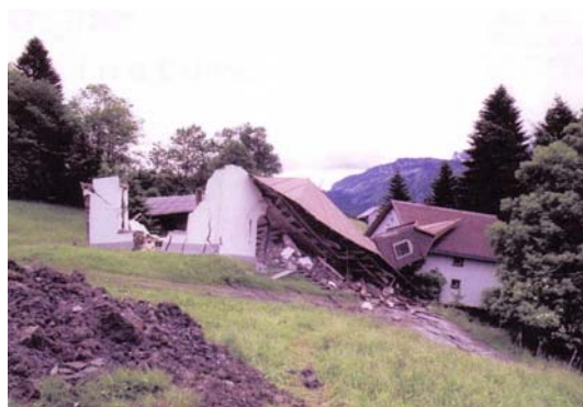
Abb. 80: Durch Hangbewegung zerstörte Rindberg-Kapelle (Aufnahme: BAUER 2000).
