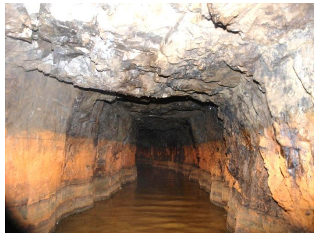
Abbildung 3-17 links: Entwässerung der Verbundgrube San Fernando-Wolf-Füsseberg-Friedrich Wilhelm über den Neuen Förderstollen der Grube Wolf (Auslauf mit Messwehr), rechts: Neuer Förderstollen Wolf mit Eisenhydroxid-Ablagerungen, welche auf unterschiedliche Wasserstände hinweisen (Fotos: POHL 2011)
