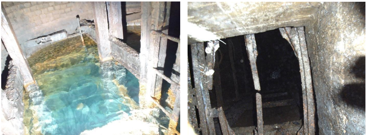
Abbildung 3-19 links: Blick auf/in Schacht Wolf von Grube Wolf (Foto: POHL 2011), rechts: Blick in Schacht 2 von Grube San Fernando (Foto: PORR 2011)
