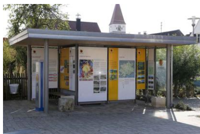
Abb. 10: Infostelle zu dem Geopark Ries in Deiningen
