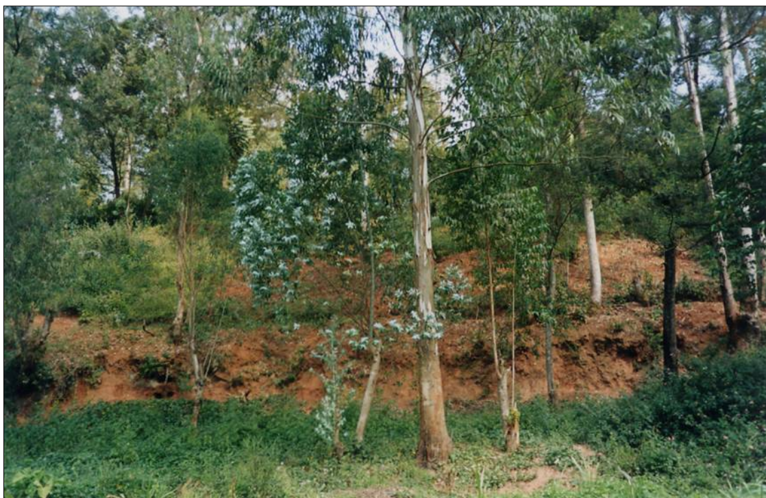
Abb. 43: Aufschluss am Unterhang des Hügels Cyarwa (Standort der Profile GSK2D und GSK2E)
