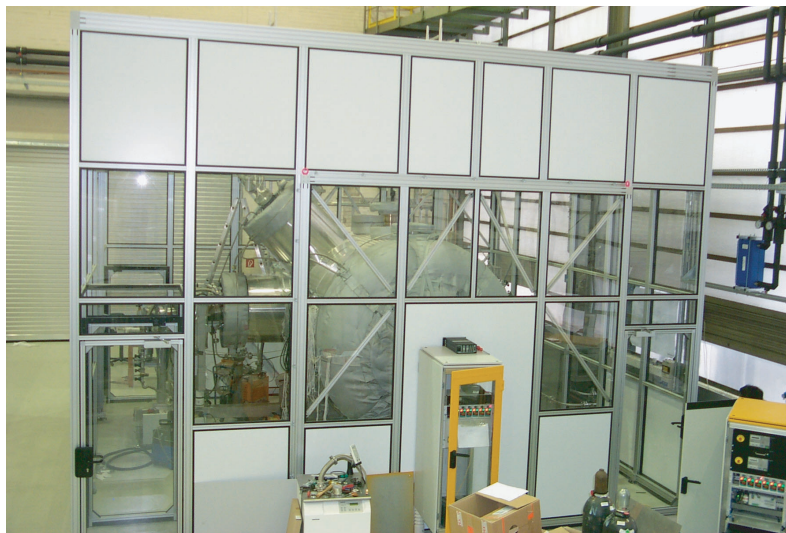
Abbildung 6.22: Aufbau des Vorspektrometers. Es ist der derzeitige Aufbau des Vorspektrometers dargestellt. Mittlerweile ist die Thermoisolation angebracht und das sog. Trockenluftgehäuse installiert. Dieses wird benötigt, um Kondensation der Luftfeuchtigkeit auf den Isolatoren zu verhindern, da das Spektrometer zur Reduktion der Ausgasrate bei einer Temperatur von -20^{\circ}\text{C} betrieben werden soll.
