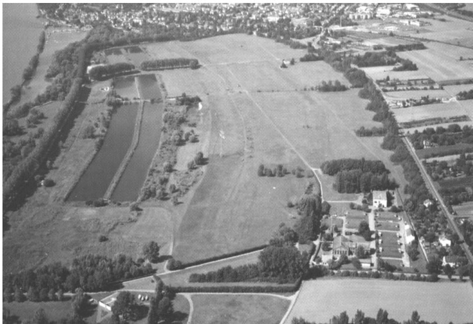
Foto 3-1: Luftbildaufnahme des Wasserwerksgeländes [BERGER, aus HESSENWASSER INTERN, 2004]
