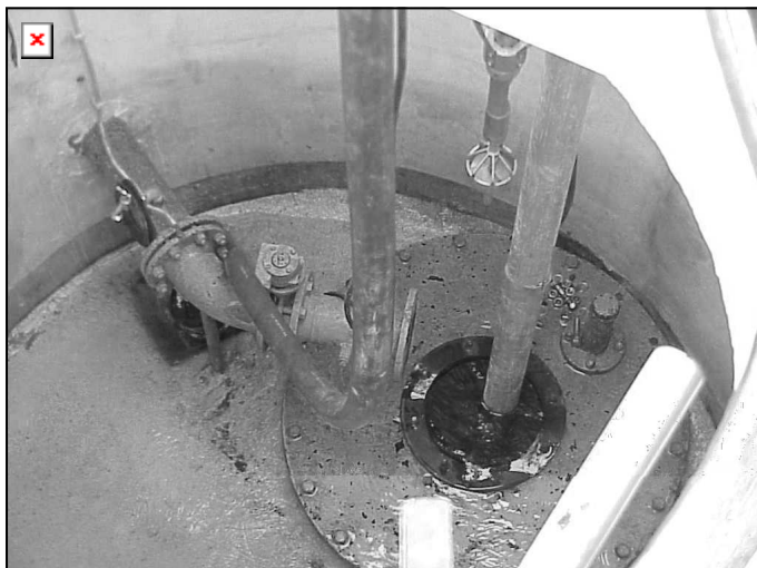
Foto 4-5: Flowmeter, das (entlang der Pumpensteigleitung) in den Brunnen abgesenkt wird [WIACEK, 2004]
