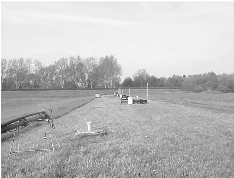
Foto 3-2: Westteil der Brunnengalerie (Wiacek, 2005)
