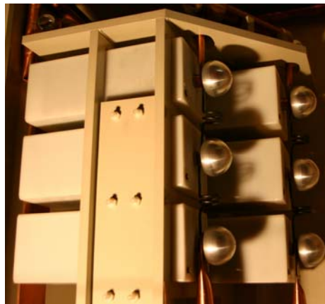
Abbildung 6: Die sechs Kondensatoren.
