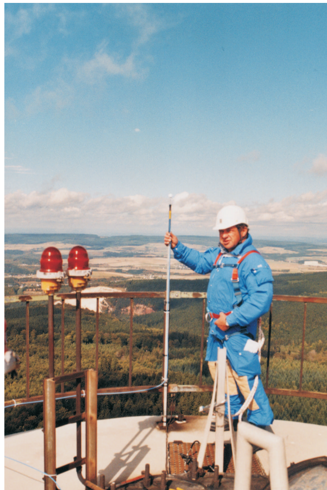
Abbildung A.4: Aufbau des Kollektors an der Turmspitze, dessen Meßdaten mit F_O bezeichnet waren.
