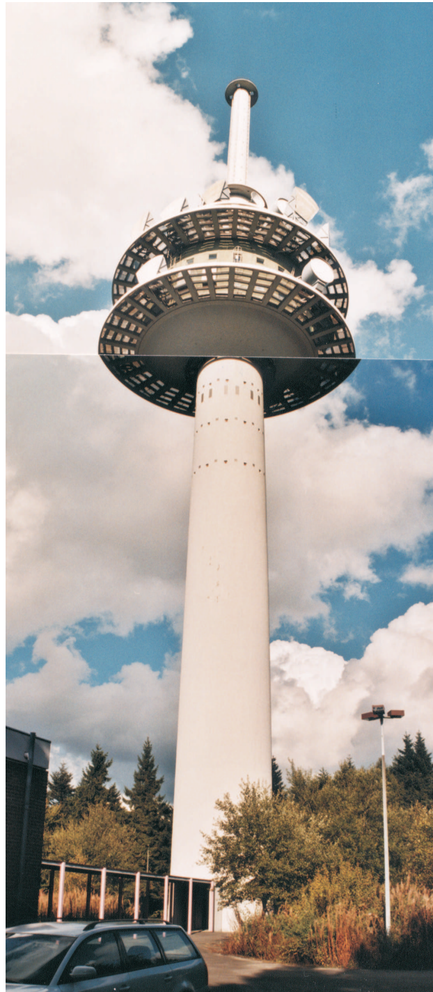
Abbildung A.3: Gesamtansicht des Fernmeldeturmes Morbach 3.
