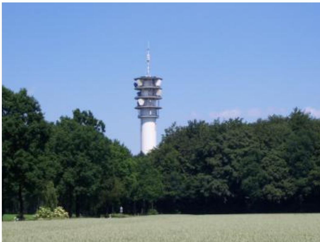
Abb. 82: Die Funkübertragungsstation in der Nähe des niedersächsischen Egestorf wird vom Land Niedersachsen auch als Feuerwachturm genutzt. Die Zweitnutzung als Feuerwachturm spart dem Land erhebliche Kosten, da die Unterhaltungskosten eines reinen Feuerwachturms entfallen.
