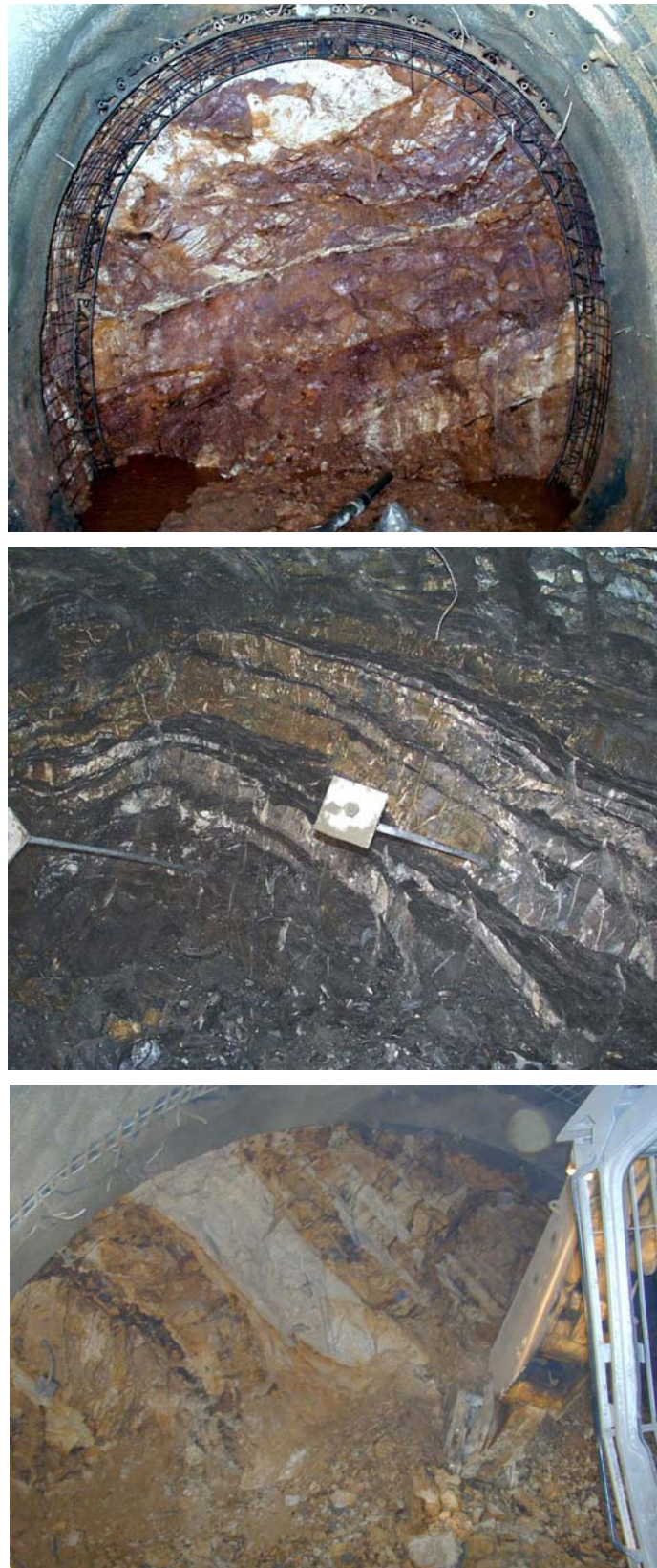
Abbildung 4-5: Typische geologische Verhältnisse im Vortrieb Oben: Stark verwitterter Tonstein mit dm-mächtigen Sandsteinzwischenlagen im Drainagestollen Mitte: Verfaltete, schwach verwitterte Ton- / Sandstein-Wechselagerung im NBS-Tunnel Unten: Durch kaolinitische Verwitterung entfärbt Tonsteine in der Kalotte des NBS-Tunnel
