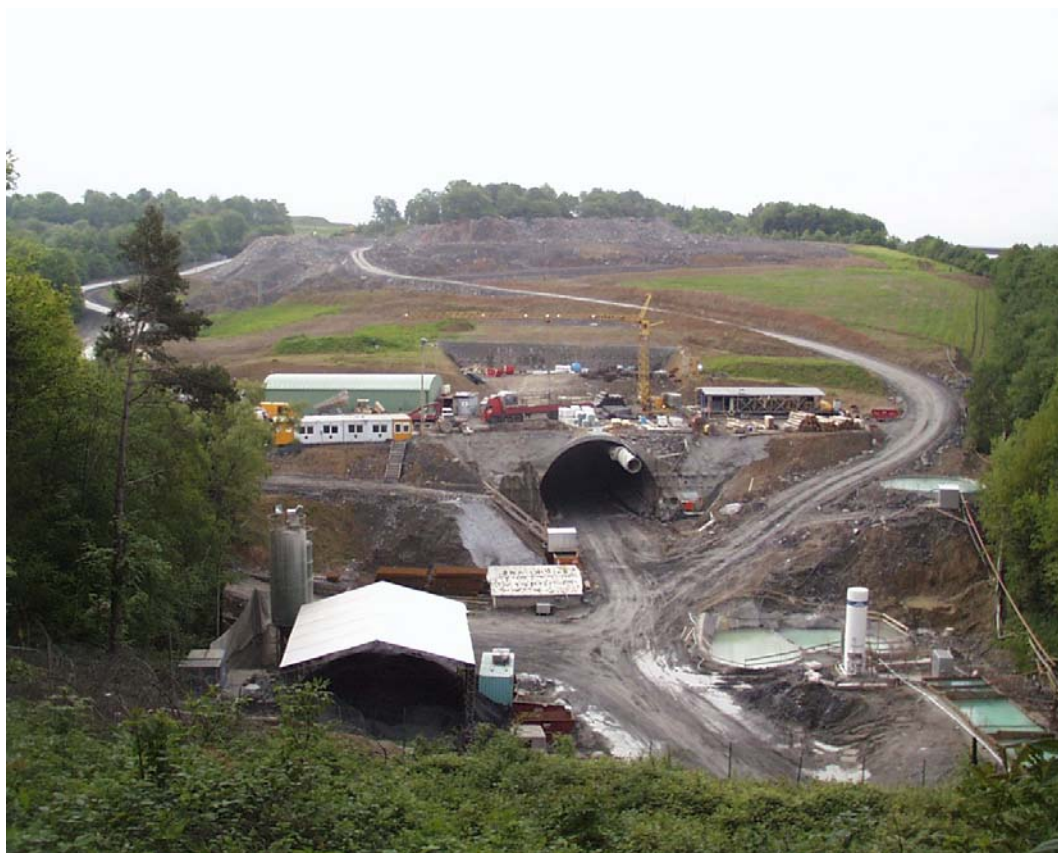
Abbildung 4-3: Blick auf das Nordportal des Tunnel Fernthal. Zu erkennen sind die Baustelleneinrichtungsfläche und der Anschlag des bergmännischen Tunnels im Vordergrund sowie der zu unterquerende Höhenzug mit der Basaltkuppe und der Deponie
