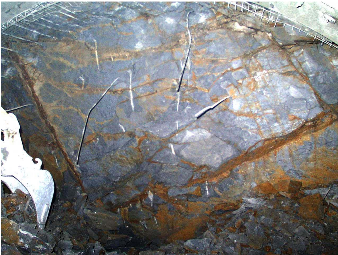
Abbildung 5-3: Dominante Längs- und Querklüftung in einem schwach verwitterten Tonsteinen
