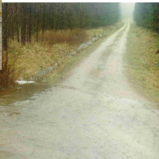
Fotos 5 und 6: Hochwasserabfluss vom Hauptwegenetz im Testgebiet Soonwald, Frühjahr 2001
