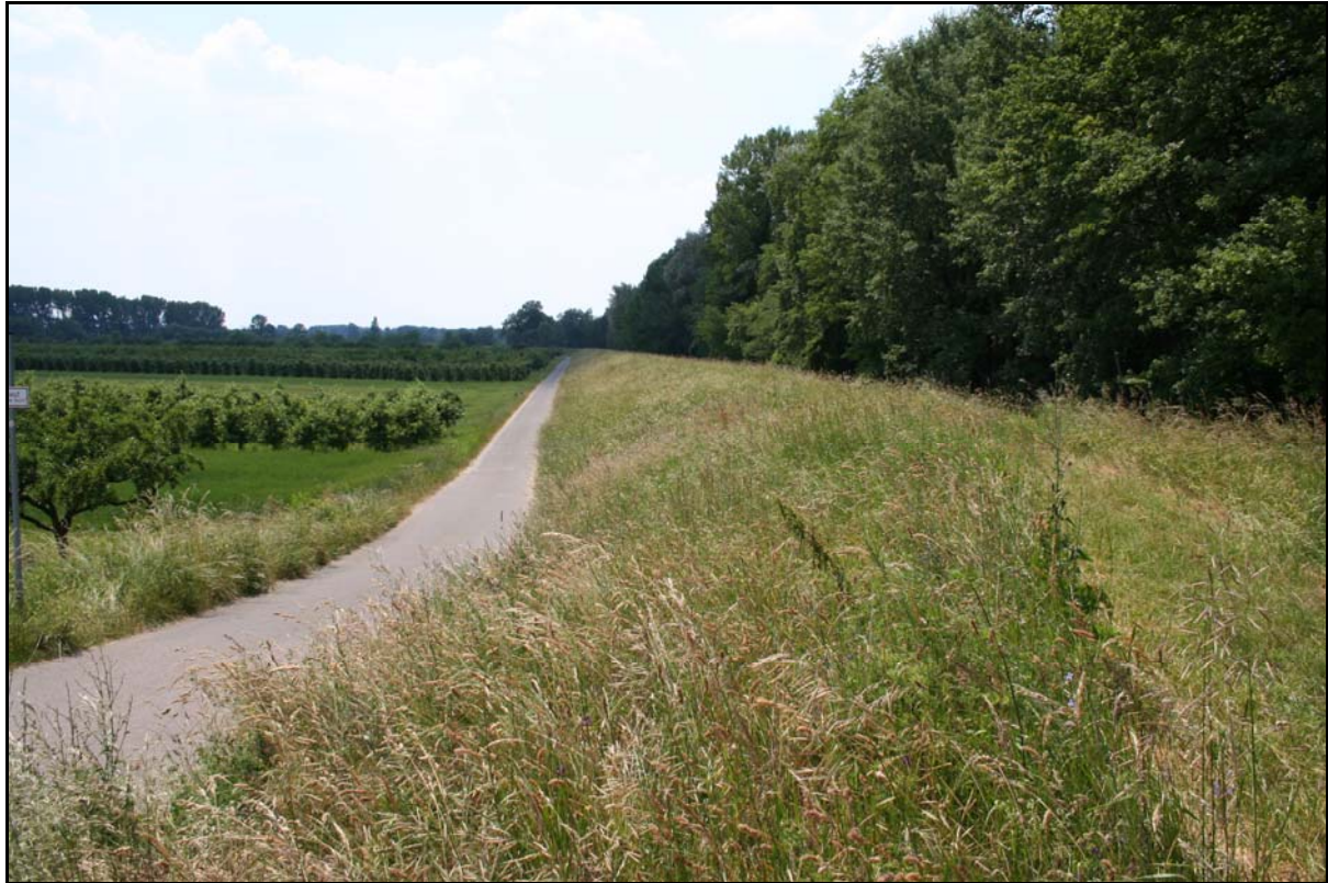
Abb. 9: Hochwasserschutzdamm hinter der Hartholzaue NSG „Sandlache“ (Zonen HE4b und HE5)
