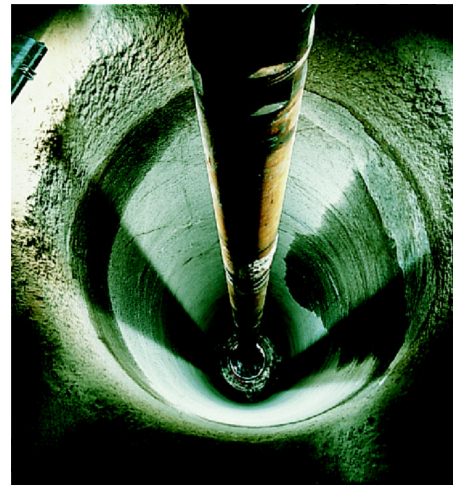
Fig. 2.2. Picture of a canister hole ( posiva.fi ).
