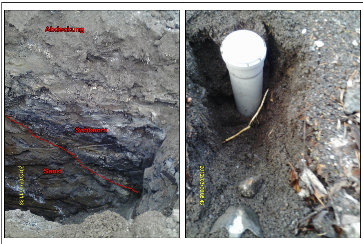
Abbildung 47:links: Untergrundaufbau am Rande des Schlammteiches, rechts: alte Sande am Südrand des Standort 2
