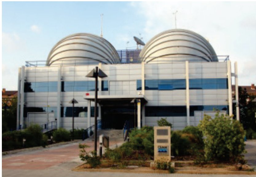
Abbildung 4.1: Die Atmosphärensimulationskammer EUPHORE in Valencia, Spanien. Zu sehen ist das die Labore beinhaltende Gebäude mit den beiden identischen halbkugelförmigen Simulationskammern. Diese können, wie dargestellt, durch Metallvorhänge vom Sonnenlicht abgeschirmt werden, um Tages- und Nachtzyklen zu simulieren.
