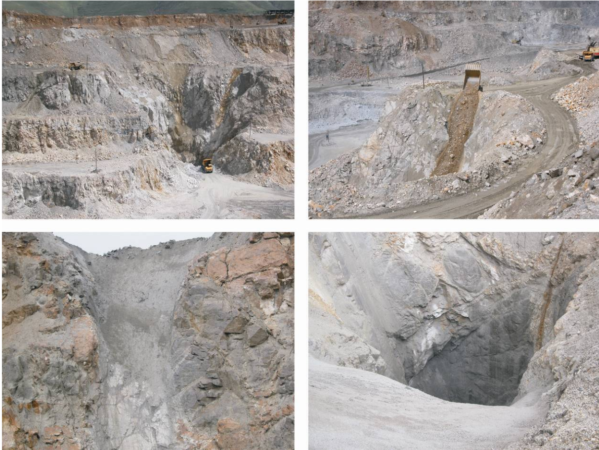
Bild 8.6: Tagebau Kajaran – Kippvorgang, Kippstellen und Rollochmund (Quelle: DR. MARTIN KIRSCHBAUM, Zeitz)
