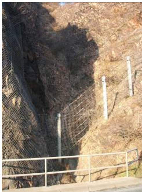
Bild 4.1: Steinschlag- / Erosionsrinne am Rotenfelsmassiv mit Steinschlag-schutznetzen (R 3417442, H 5520805) (Quelle: Autor)
