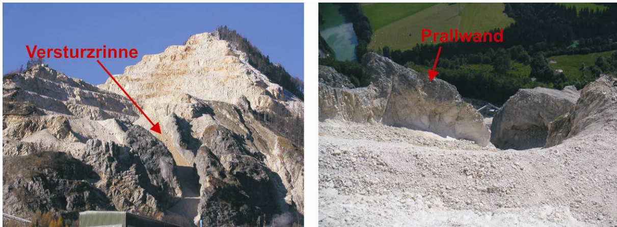
Bild 8.3: Sturzrinne im Kalkwerk Steyrling (teilweise abgebaut), Prallwand (Quelle: Werksleiter voestalpine Stahl, BJÖRN KIRCHNER 2006)
