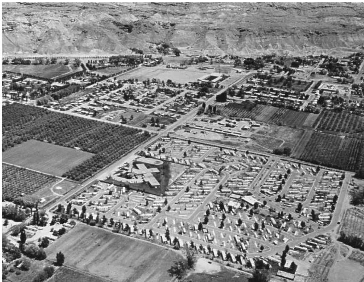
Abb. 13 Der nordwestliche Teil von Moab in den 1960er Jahren. Die ursprünglich hier vorhandenen Obstplantagen werden allmählich durch „Trailerparks“ ersetzt – die einfachste Art, Wohnraum zu schaffen. Im Bild der Grand Oasis Trailer Park (heutiger Name), am linken Rand des Parks das 1957 eröffnete Allen Memorial Hospital. Das Gebäude auf der Freifläche in der oberen Bildmitte ist die von Charlie Steen gestiftete Helen McKnight School. Unterhalb des neuen Schulgeländes ist das von Charlie Steen angelegte Wohnviertel „Steen-ville“, heute sind die Trailer mehrheitlich durch Einfamilienhäuser ersetzt (Foto: Dan O’Laurie Canyon Country Museum, Moab, Utah).
